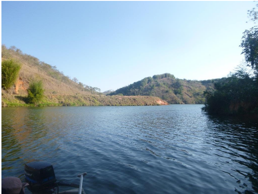
Figura 23. Registro fotográfico do ponto de amostragem LOU 30, localizado no reservatório de Louriçal, na área de influência do AHE Simplício – Queda Única.
