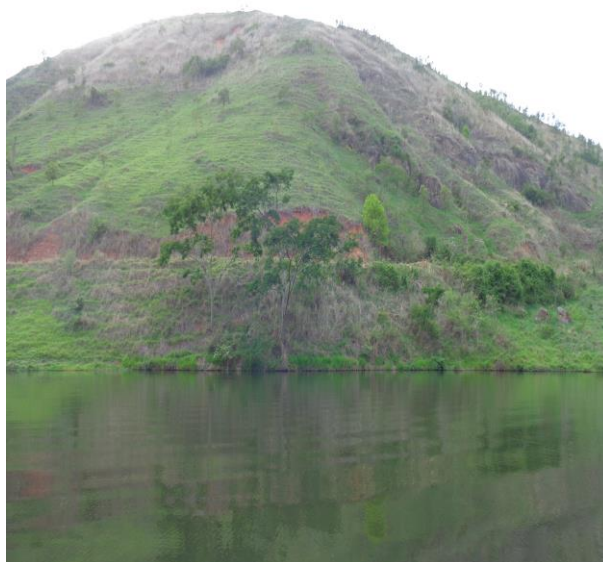
Figura IV-15 – Estação LOU 20, a montante do Dique Alga2 - reservatório de Louriçal.
