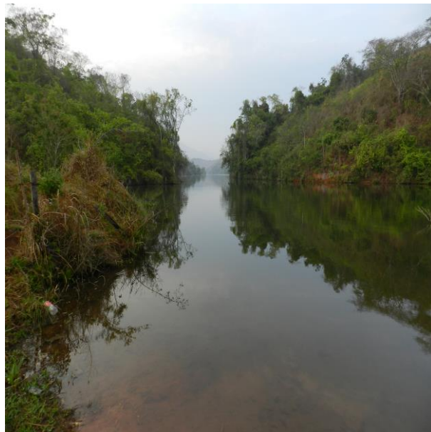
Figura IV-11 – Estação ARE 20, montante do Dique Alga1 - reservatório de Louriçal.
