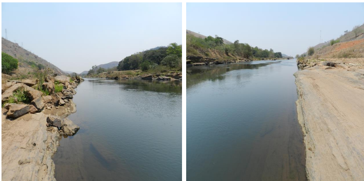
Figura IV-8 – Estação PRB 90, no rio Paraíba do Sul, a montante do canal de fuga da AHE - Simplício.
