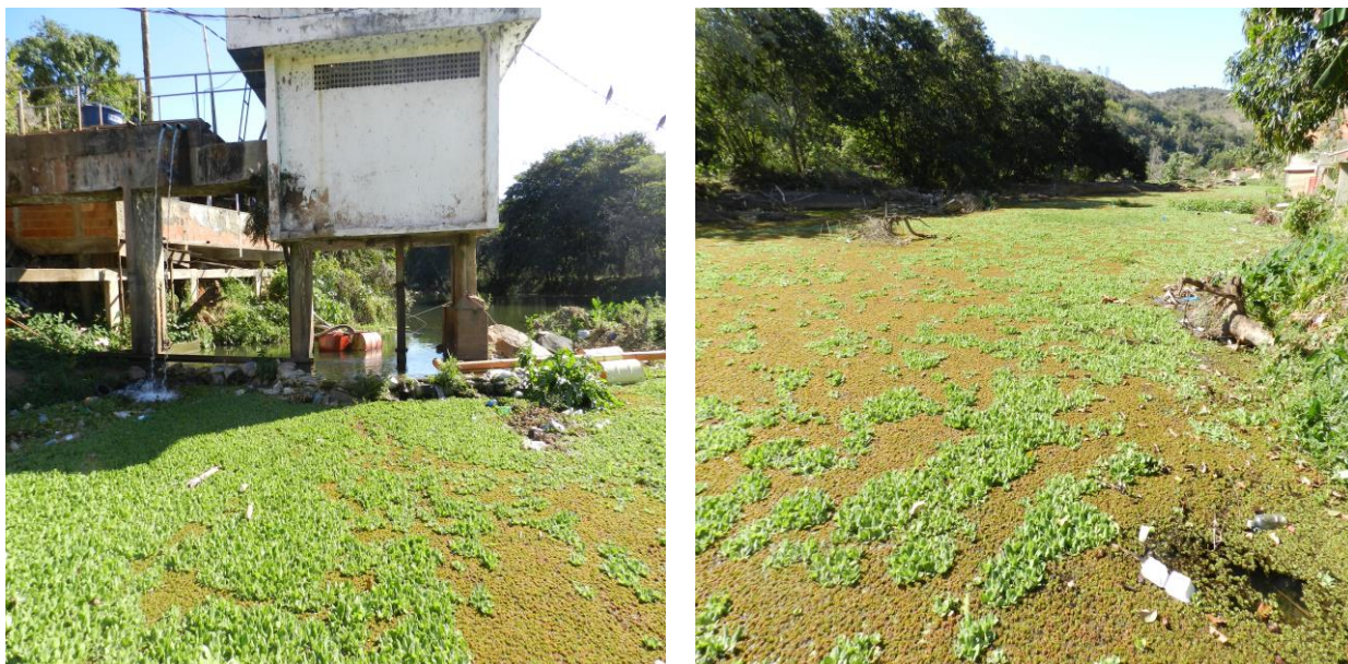
Figura IV-5 – Estação PRB CEDAE, no rio Paraíba do Sul, estação de captação de água da cidade de Sapucaia/RJ.
