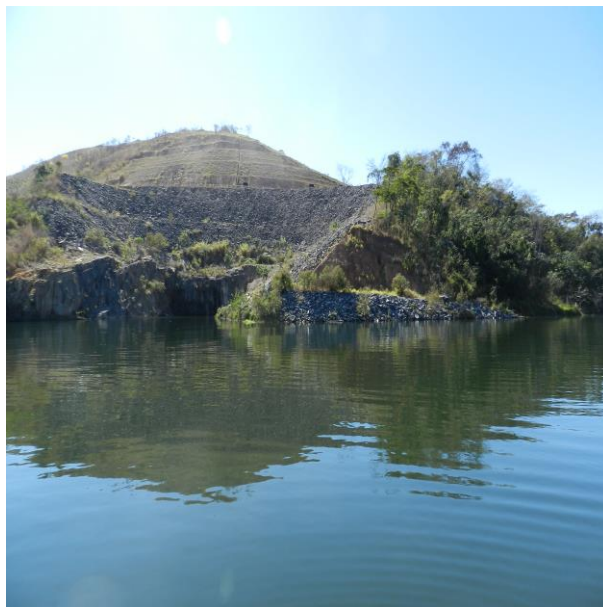
Figura IV-16 – Estação LOU 25, a jusante do Dique Alga2 - reservatório de Louriçal.
