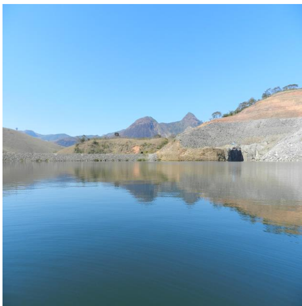
Figura IV-13 – Estação ARE 30, a montante do Dique Louriçal - reservatório de Louriçal.
