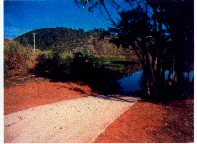
Foto 2: Vista da rampa pronta e da limpeza do local.
