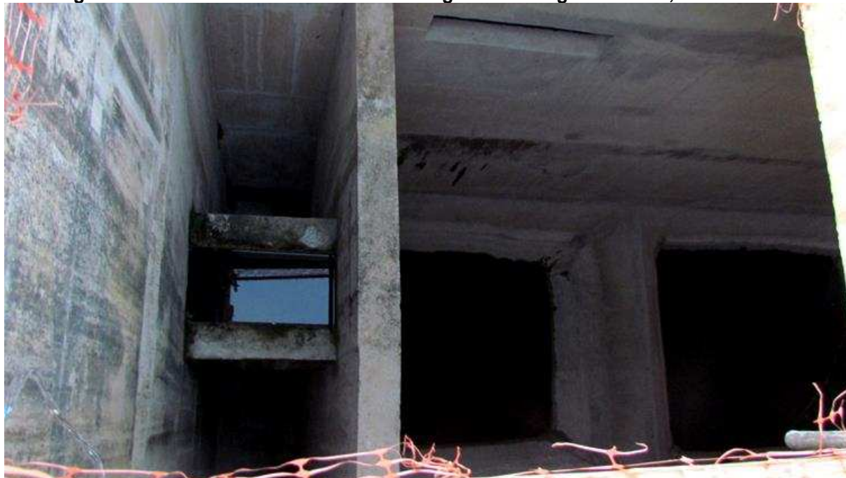
Figura 30 – Pontos de armazenamento de água na Barragem de Anta, vistos do alto
