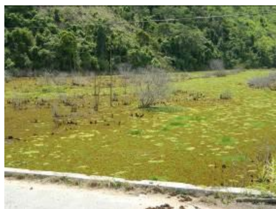
Figura 52 Área alagada na altura da ponte sobre o Córrego Cascatas
