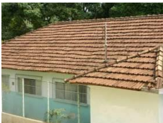
Figura 150 Vista externa do telhado da Escola Municipal do Aterrado
