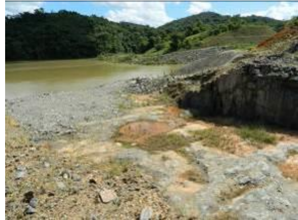
Figura 32 Visão do desvio para vazão de tromba d'água no reservatório Tocaia
