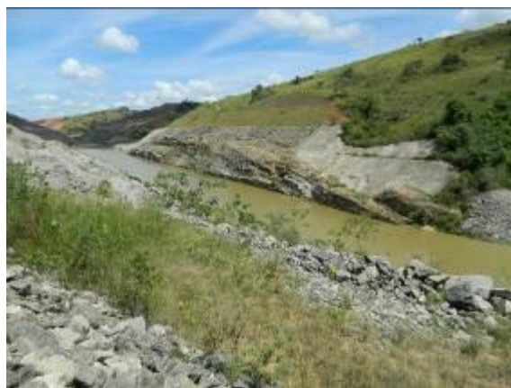
Figura 39 Emboque do Túnel 1
