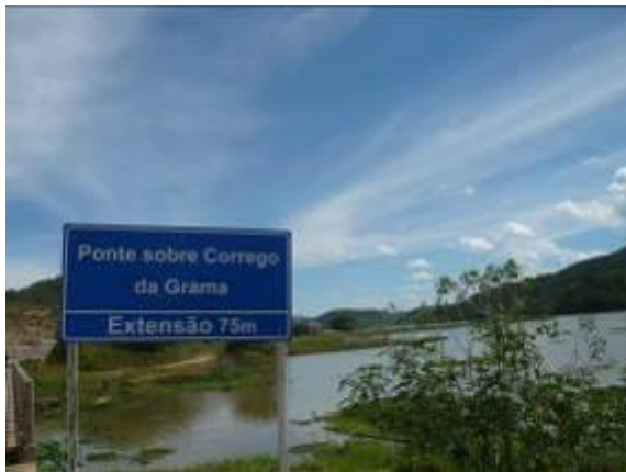
Figura 45 Ponte sobre Córrego da Grama (75m de extensão), BR 393 - Sapucaia/Três Rios
