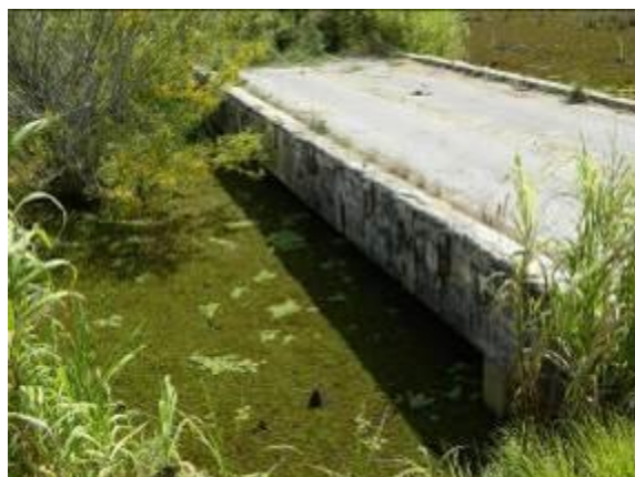
Figura 50 Vista da ponte sobre o Córrego Cascatas
