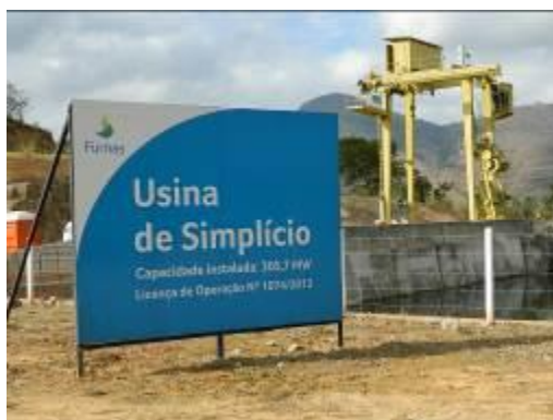
Figura 349 Entrada da Usina Hidrelétrica de Simplício
