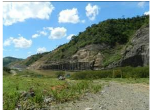
Figura 34 Desemboque do Túnel 1
