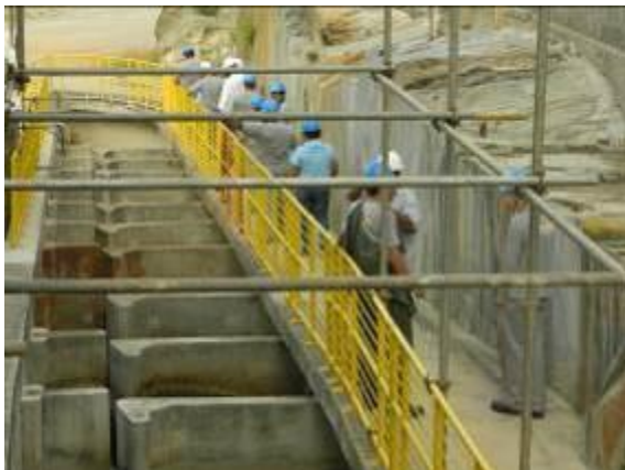
Figura 293 Vista superior da Escada de Peixes
