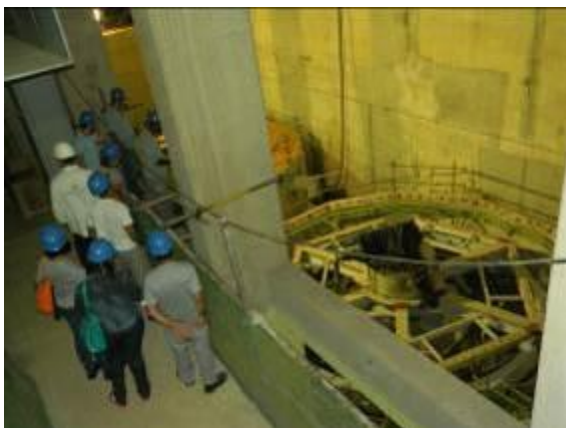
Figura 324 Visita à Casa de Máquinas e às Turbinas da Usina de Anta
