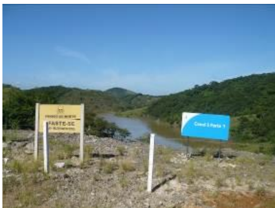
Figura 9 Identificação e sinalização da área de risco no Canal 5 – Parte 1
