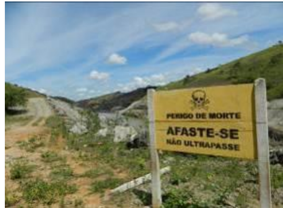
Figura 38 Sinalização da área de risco, localizada no Emboque do Túnel 1
