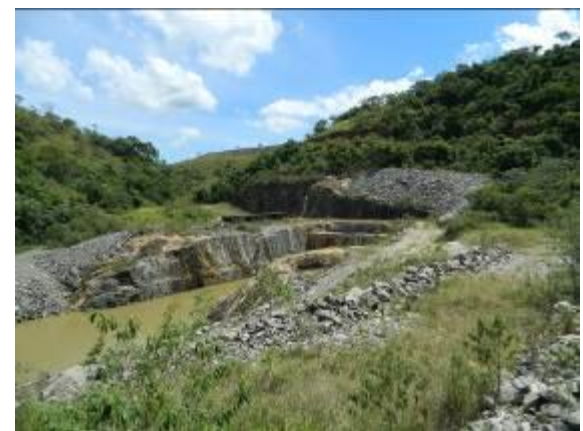
Figura 40 Emboque do Túnel 1
