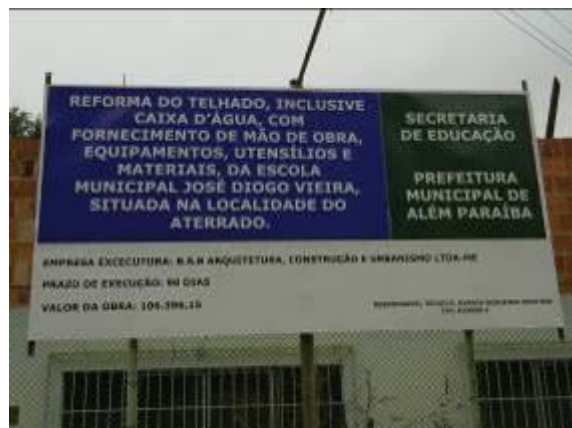
Figura 163 Previsão de 90 (noventa) dias para a conclusão da obra
