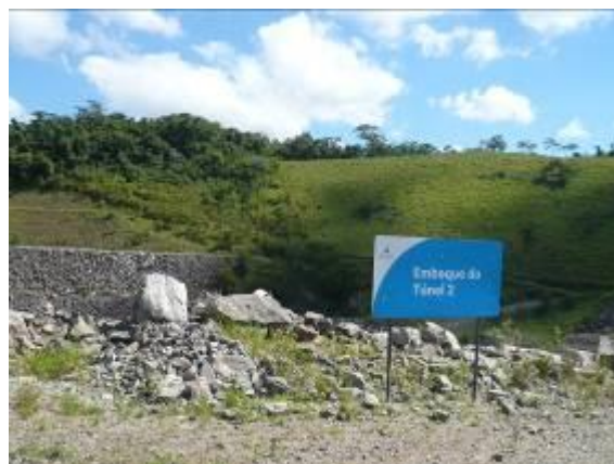
Figura 22 Identificação do Emboque do Túnel 2
