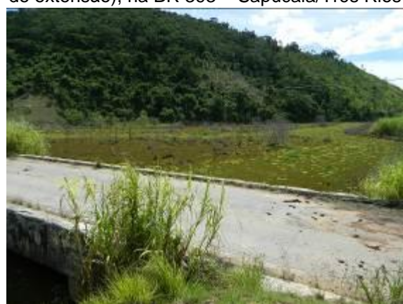
Figura 51 Antiga ponte sobre o Córrego Cascatas (atualmente, desativada)
