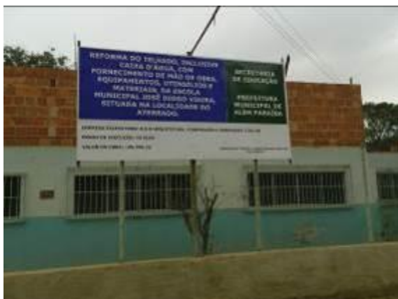
Figura 162 Reforma da Escola Municipal José Diogo Vieira, no Aterrado
