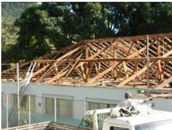
Figura 156 Reforma do telhado da Escola do Aterrado (problema: infestação de cupins)
