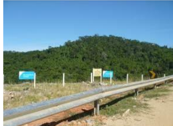
Figura 12 Identificação e sinalização da área de risco do Reservatório de Lourçal
