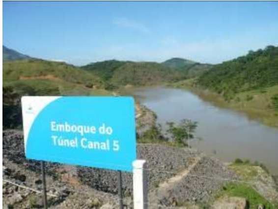
Figura 11 Identificação do Emboque do Túnel do Canal 5
