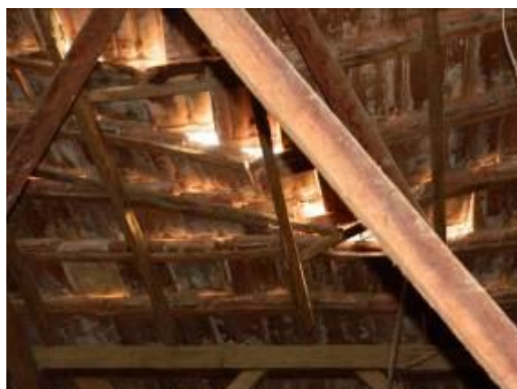
Figura 153 Interior do telhado que sofrerá reforma
