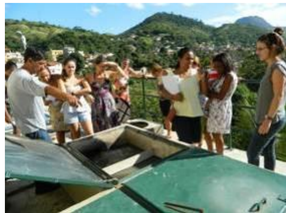
Figura 581 Visita técnica à ETE
