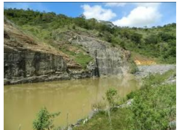
Figura 36 Desemboque do Túnel 1
