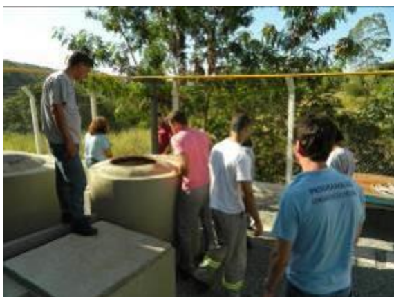
Figura 330 Funcionários do AHE Simplício atentos aos detalhes do tratamento primário
