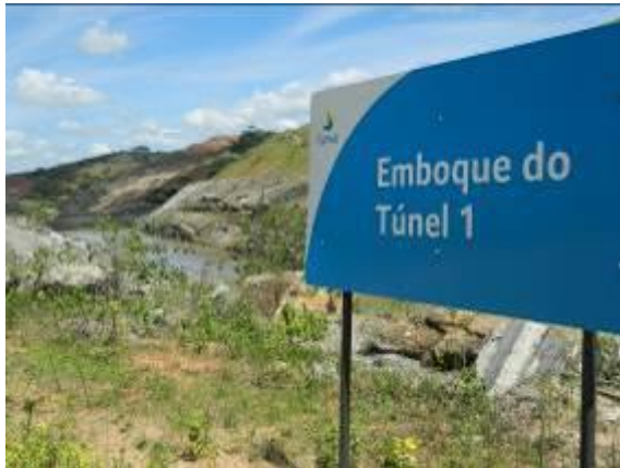
Figura 37 Identificação do Emboque do Túnel 1
