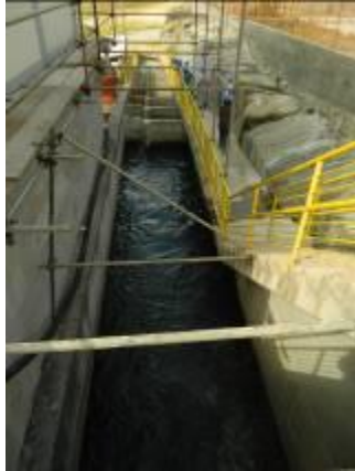
Figura 320 Vista superior da Escada de Peixes
