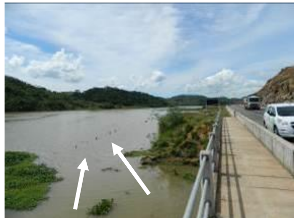
Figura 46 Detalhe para as pontas de estrutura da antiga ponte; atualmente, debaixo d'água
