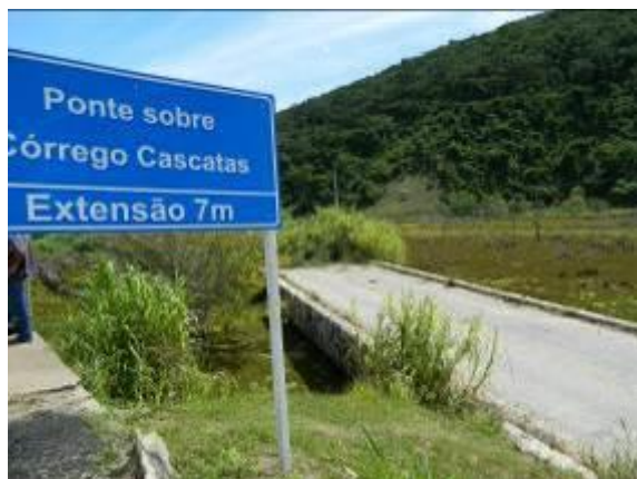
Figura 49 Ponte sobre o Córrego Cascatas (7m de extensão), na BR 393 – Sapucaia/Três Rios
