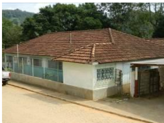
Figura 151 Vista externa do telhado que será reformado pela SME
