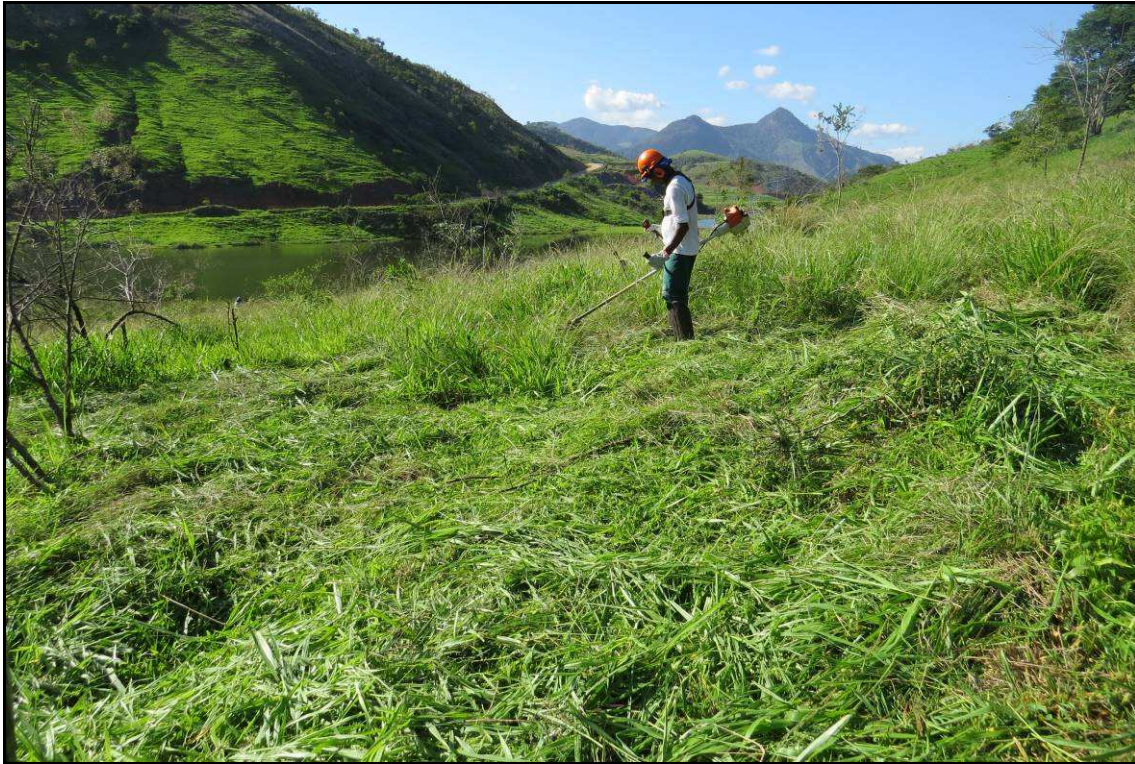
Figura 02: Limpeza de parte da área 05.
