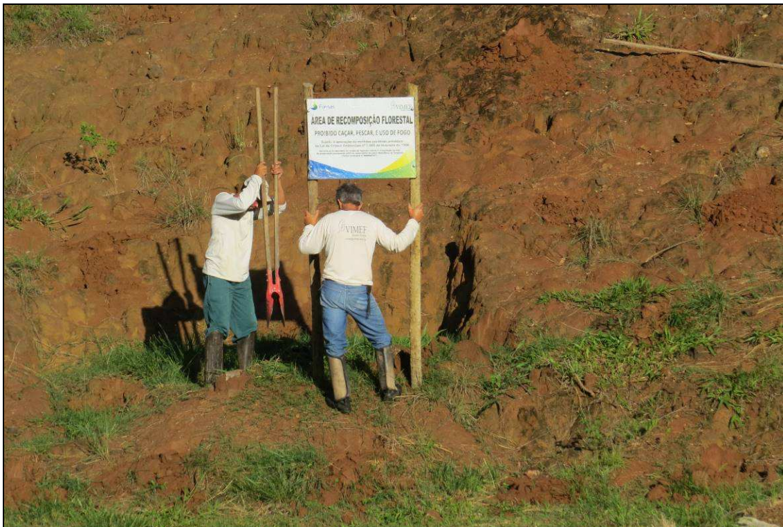
Figura 07: Instalação da placa sinalizadora na área 05.
