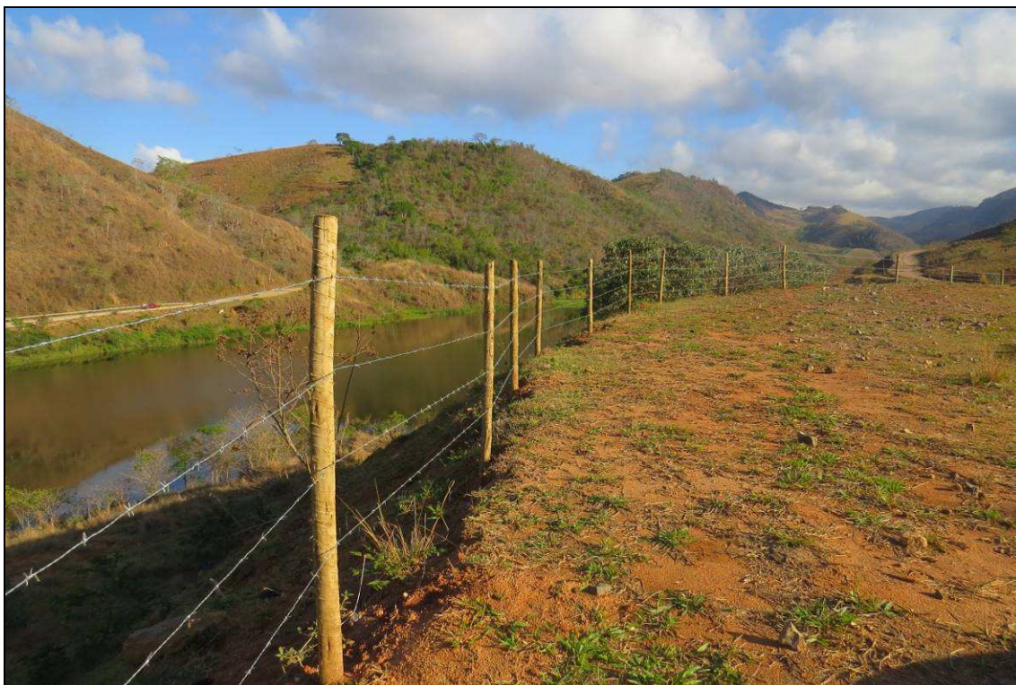
Figura 03: Parte da cerca construída (área 04).
