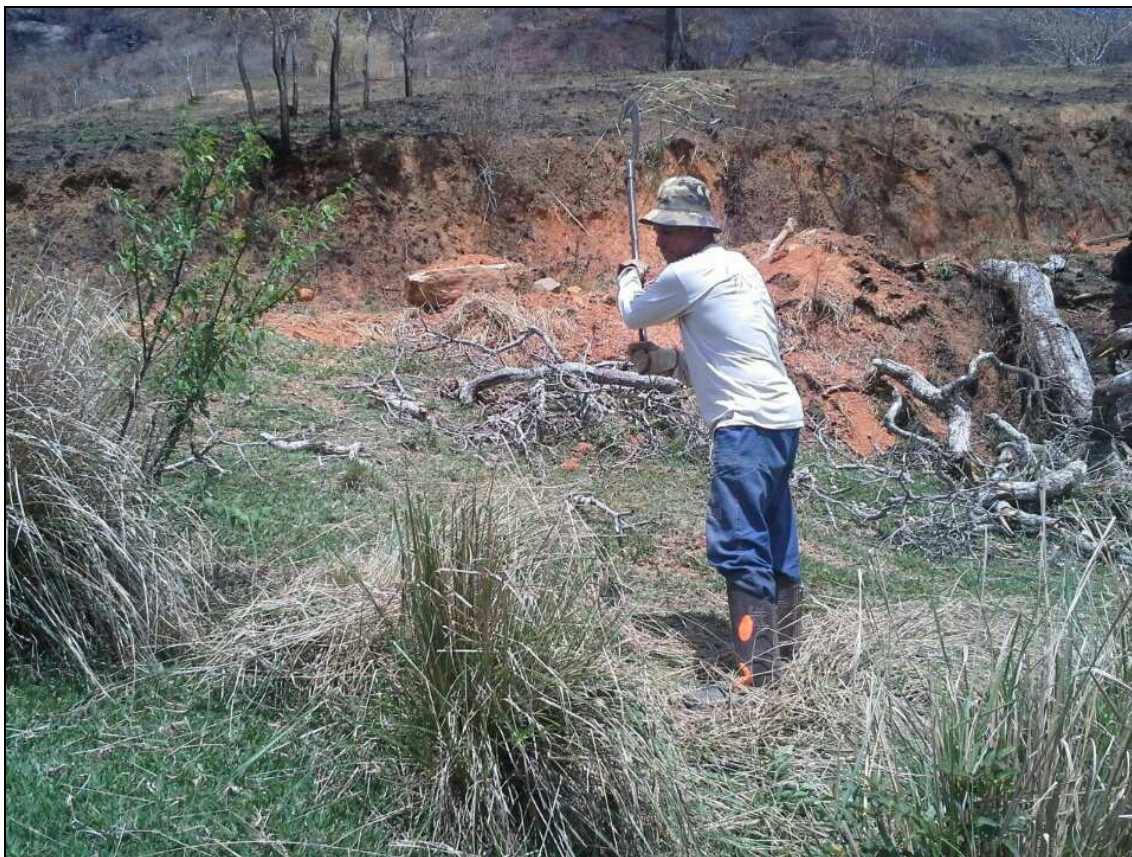
Figura 02: Limpeza da área (área 04).
