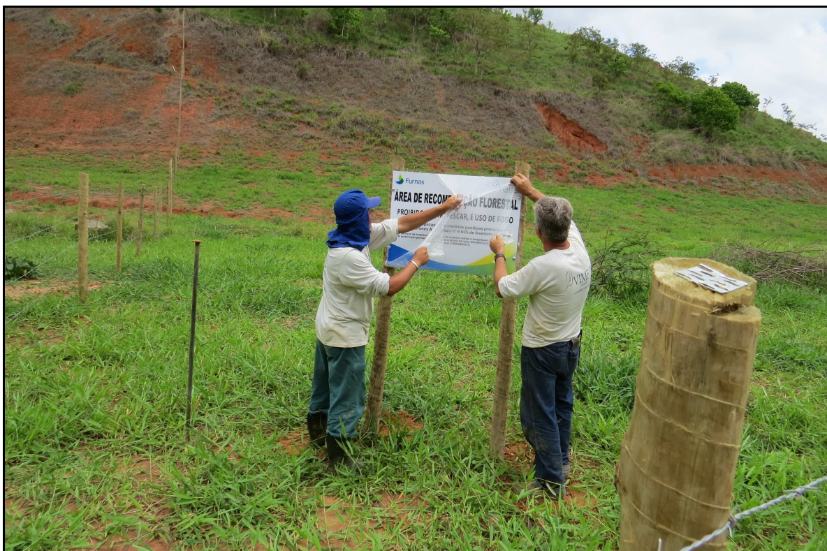
Figura 18: Placa instalada na área 03.
