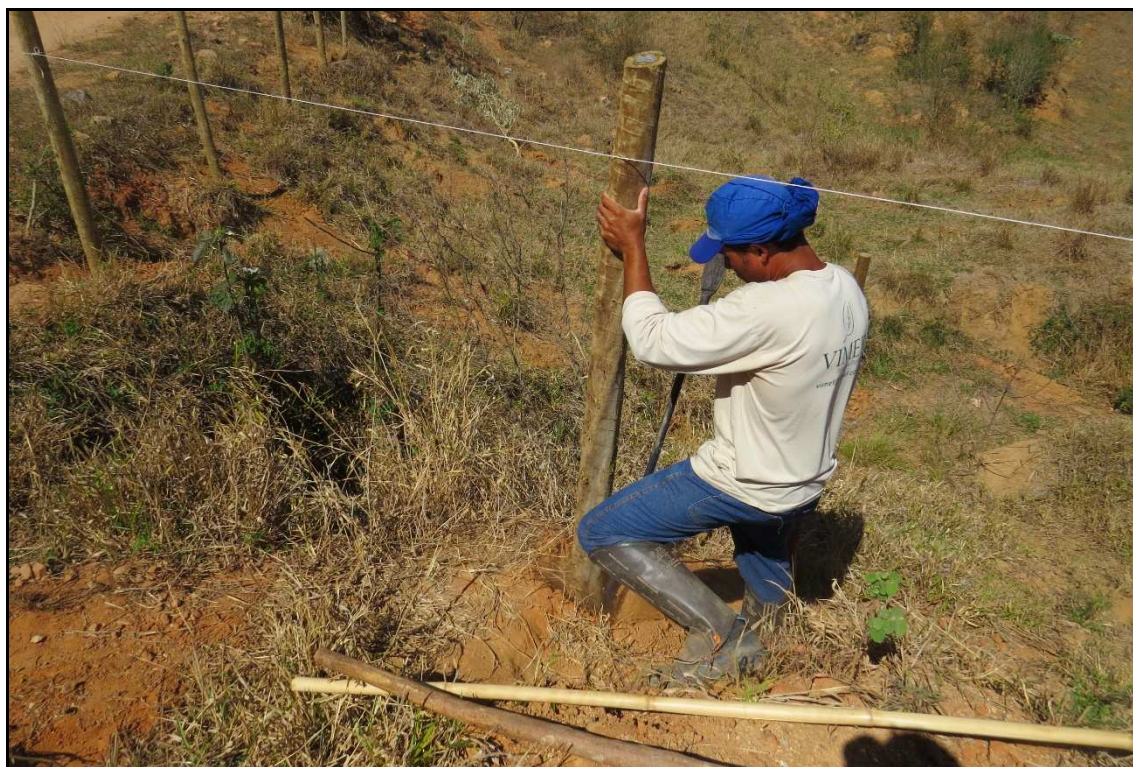
Figura 07: Ajudante florestal cravando o poste de eucalipto no solo.
