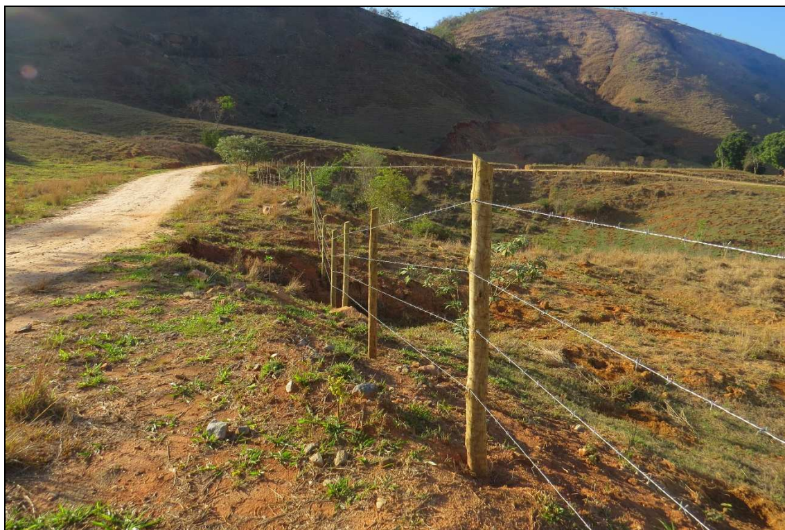
Figura 08: Parte da cerca construída (área 04).
