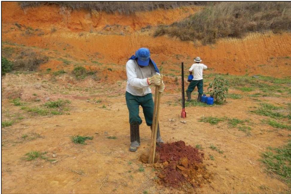
**Figura 04:** Construção da cova de 0,5 m de profundidade para cravar os postes de eucalipto.
