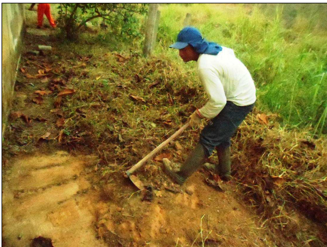
Figura 3: Retirada do capim que foi roçado.
