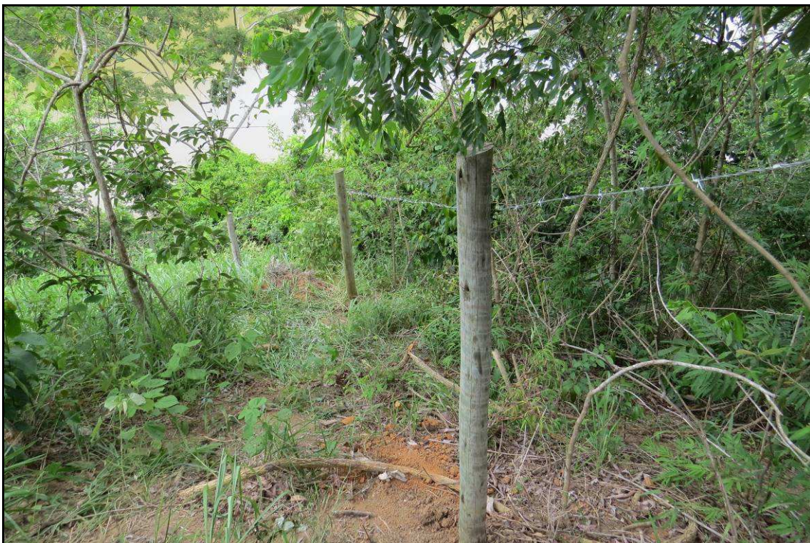
Figura 02: Cerca em construção.
