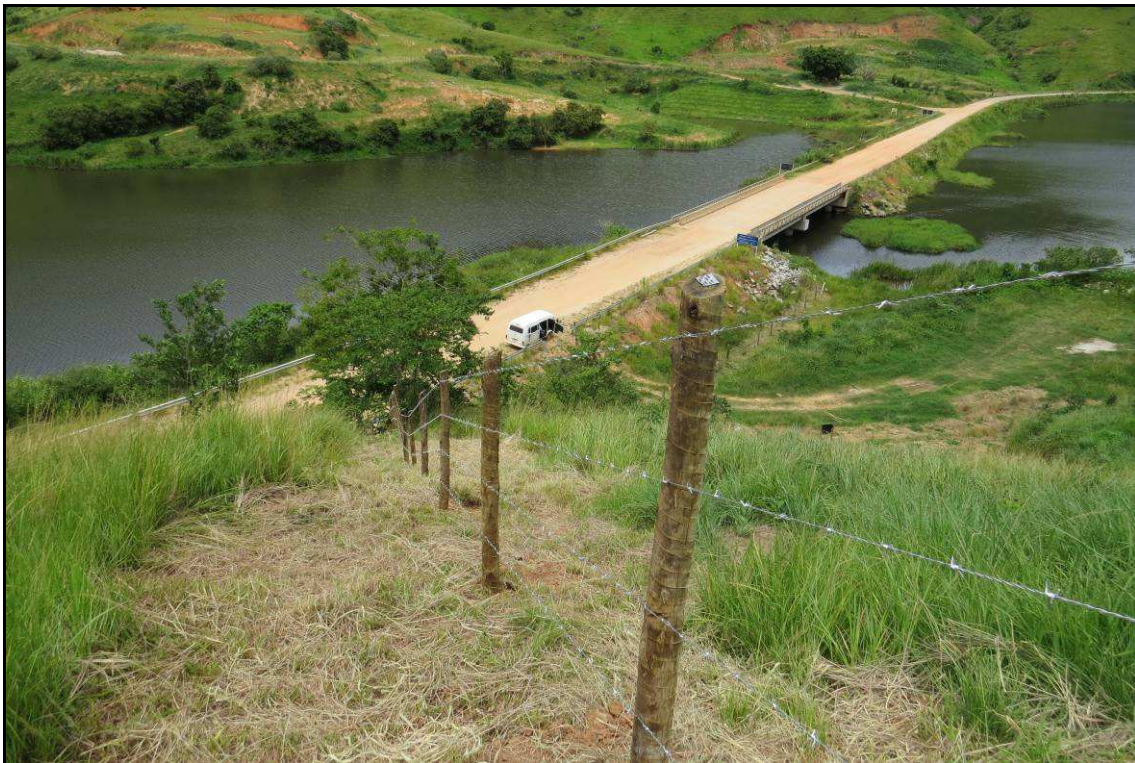
Figura 01: Parte da cerca de delimitação lateral na área 05.
