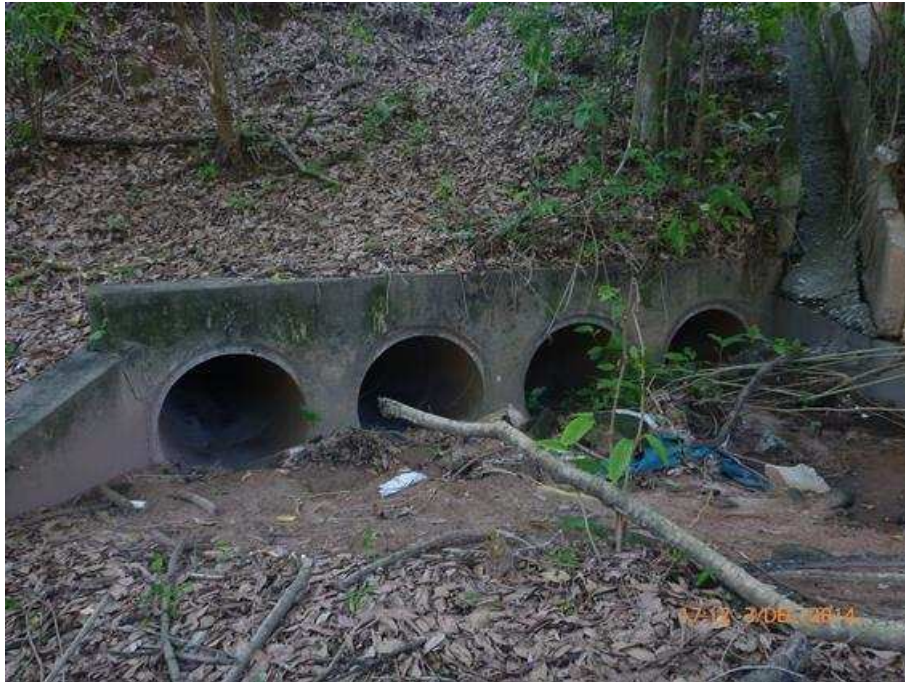
Figura 11 – Detalhe de manilhas sob a BR-393 que embora não sirva de abrigo de repouso, podem ser utilizadas como abrigo “digestório” (os animais utilizam-nas apenas para realizar a digestão).
