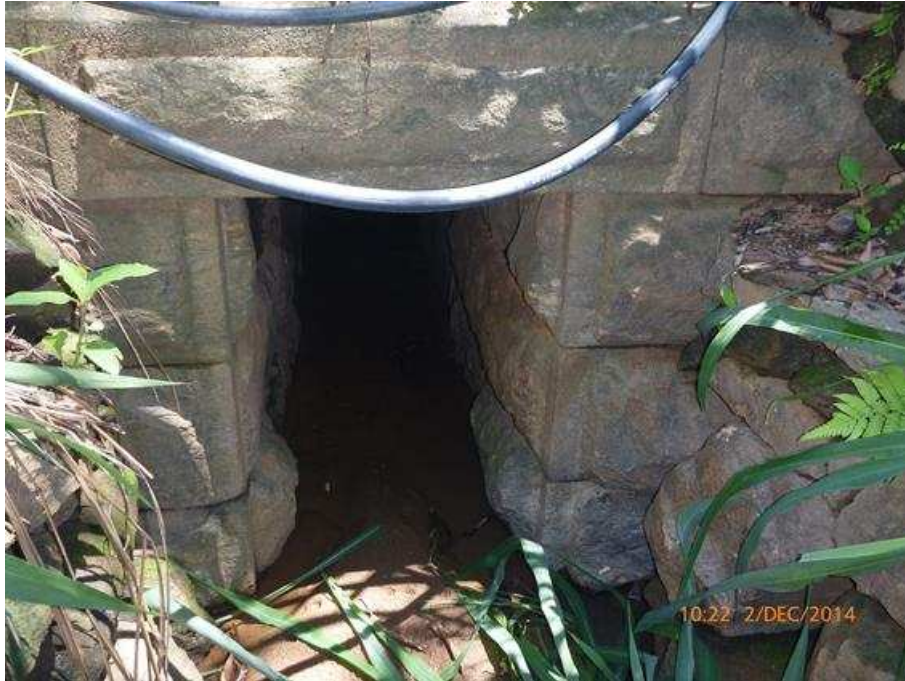
Figura 02 – Pontilhão sob a BR-393 com exemplares de Desmodus rotundus .
