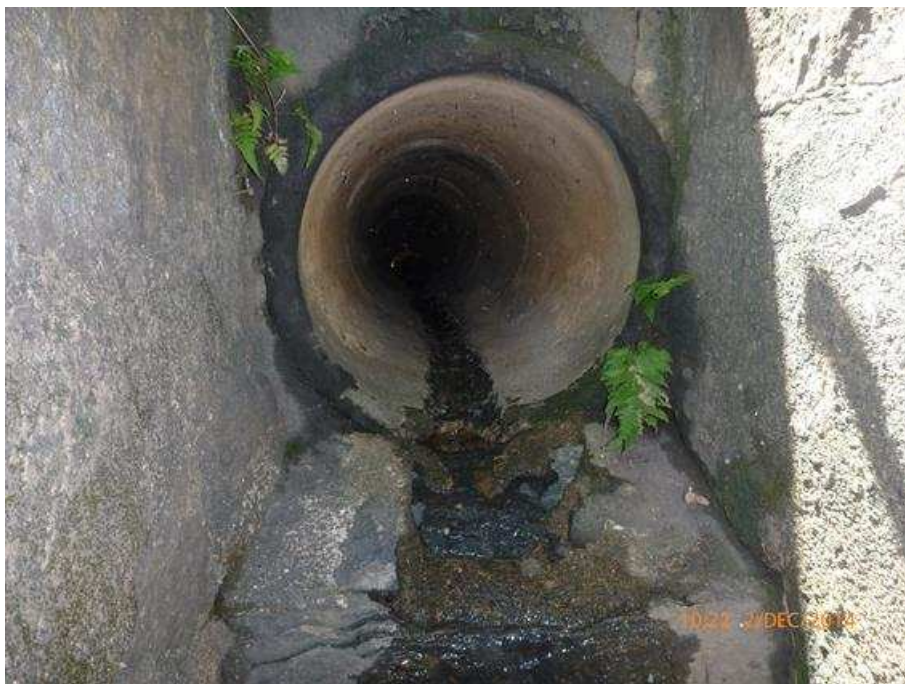
Figura 03 – Aspecto da entrada de um pontilhão tendo uma manilha como acesso sob a BR-393.
