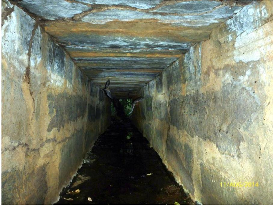
Figura 10 - Detalhe do interior de um “pontilhão” com várias pedras interligadas.
