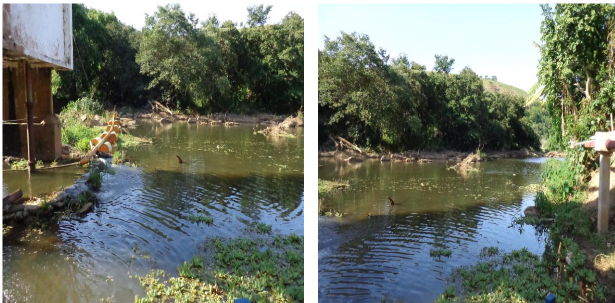
Figura IV-9 – Estação PRB CEDAE, no rio Paraíba do Sul, estação de captação de água da cidade de Sapucaia/RJ.
