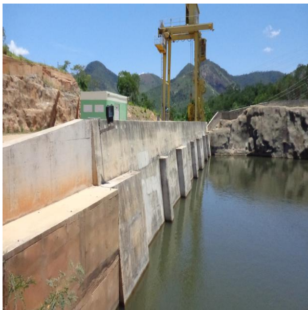
Figura IV-31 – Estação ANT 10, Reservatório de Antonina.
