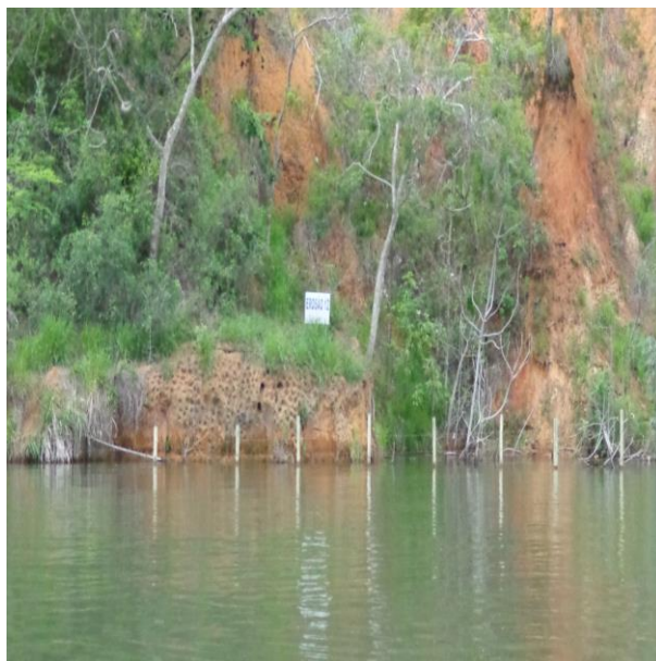
Figura IV-23 – Estação LOU 30, no Canal Área 5 - reservatório de Louriçal.
