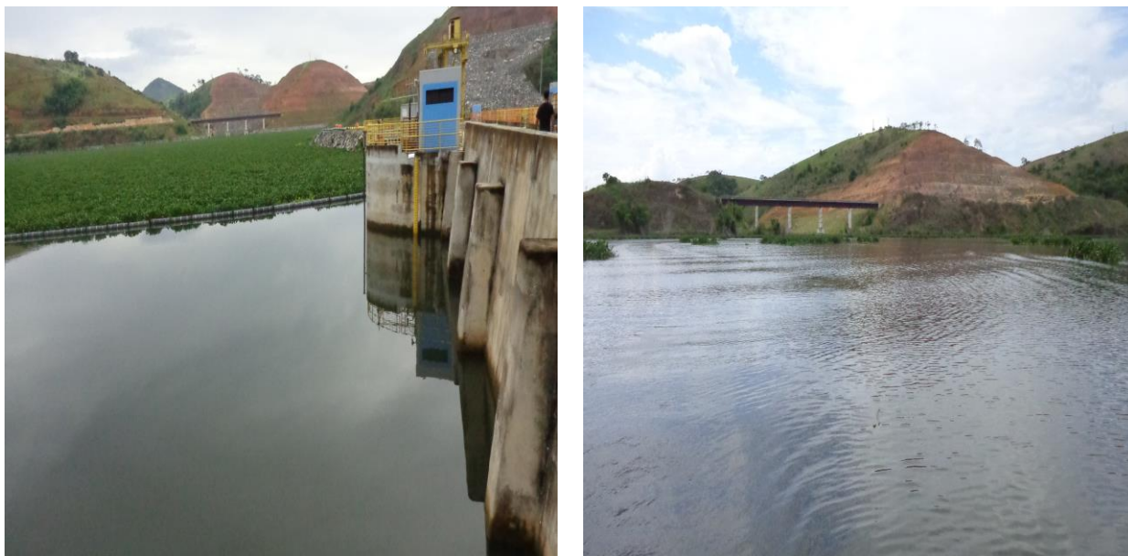
Figura IV-5 – Estação PRB 40, no rio Paraíba do Sul, a montante da barragem da AHE Anta.
