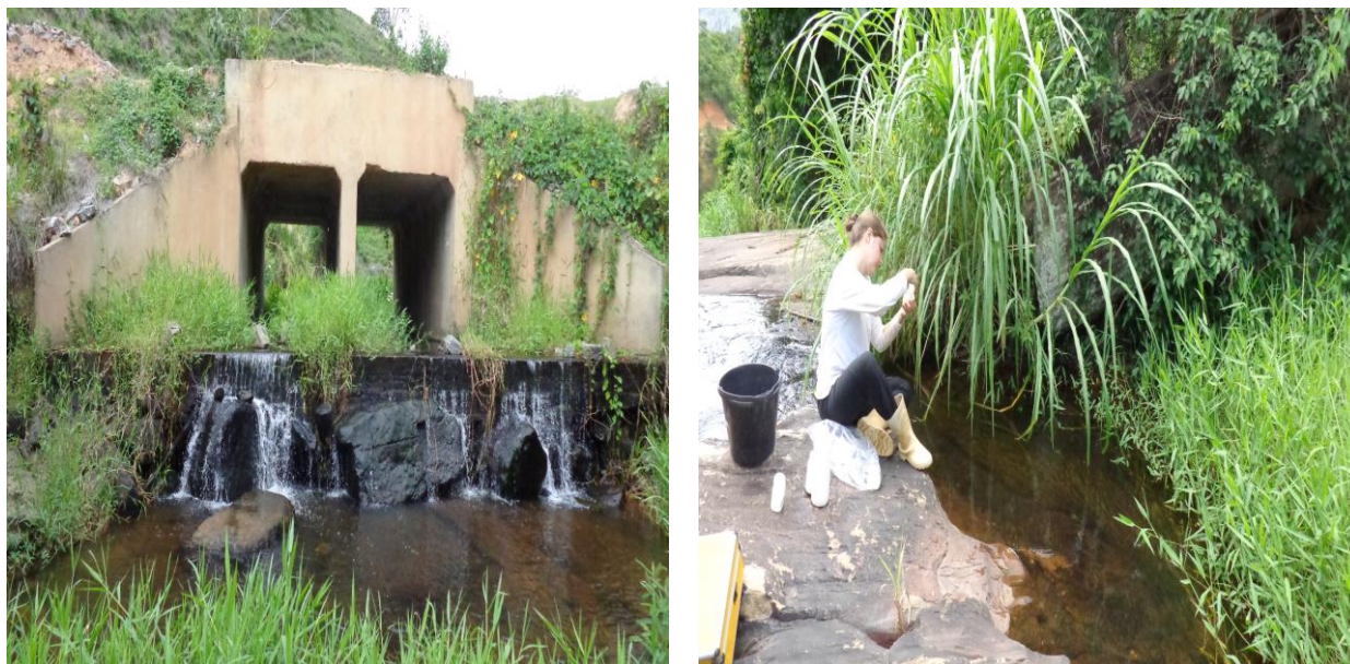
Figura IV-14 – Estação TOC 10, no córrego Tocaia, a montante do reservatório Tocaia.
