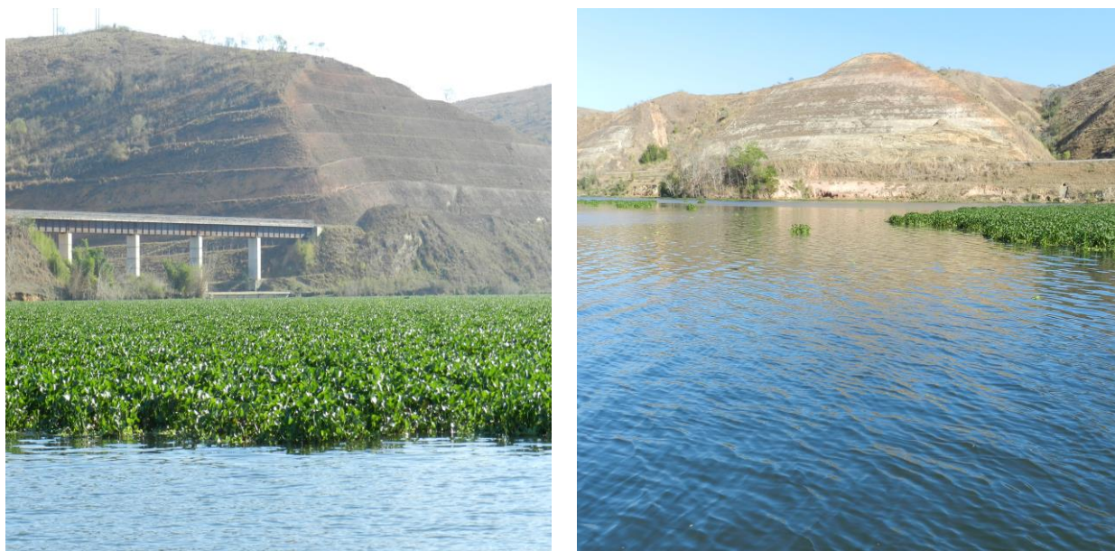
Figura IV-6 – Estação PRB 40, no rio Paraíba do Sul, a montante da barragem da AHE Anta.
