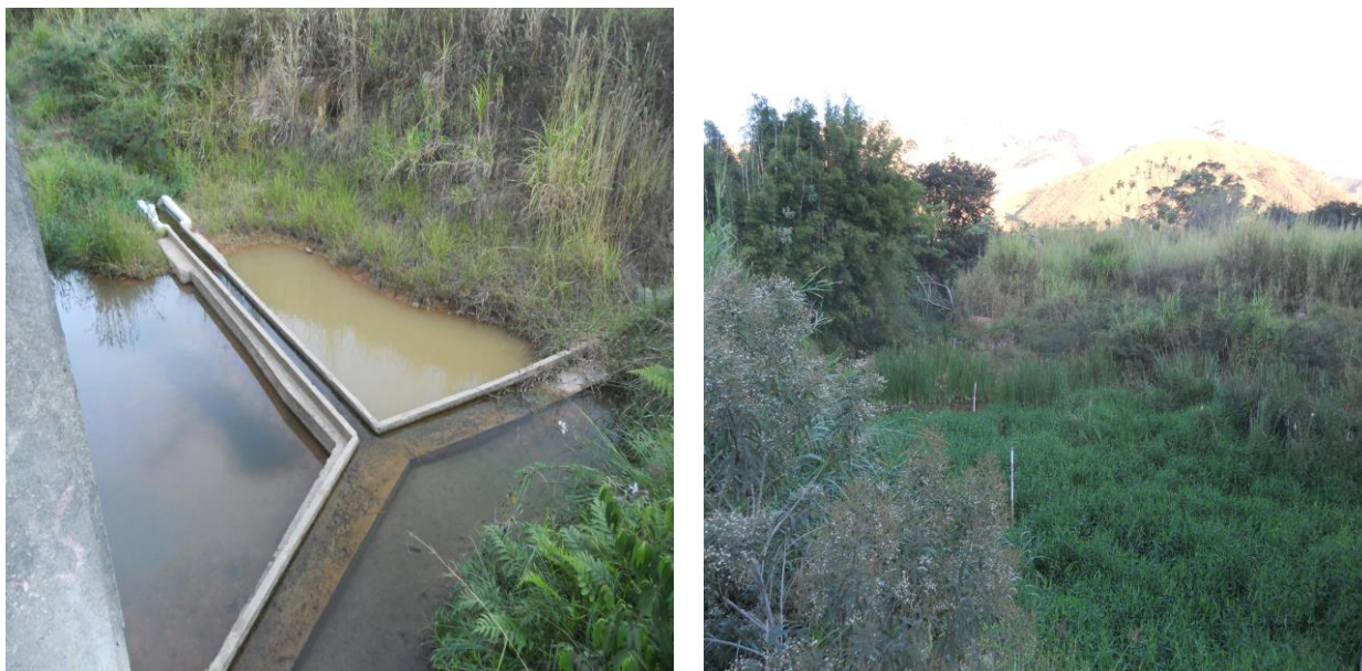
Figura IV-27 – Estação PTR 20, córrego do Prata.
