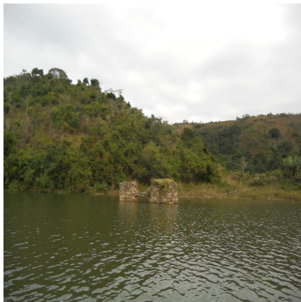
Figura IV-19 – Estação ARE 25, jusante do Dique Alga1 - reservatório de Louriçal.
