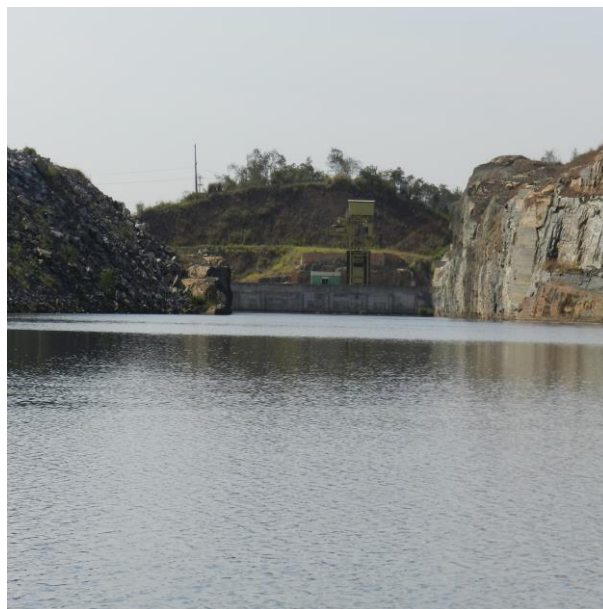
Figura IV-32 – Estação ANT 10, Reservatório de Antonina.
