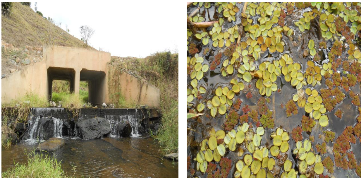
Figura IV-15 – Estação TOC 10, no córrego Tocaia, a montante do reservatório Tocaia.
