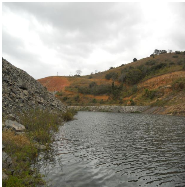
Figura IV-31 – Estação CNL 10, Canal entre os Reservatórios de Anta e Tocaia.
