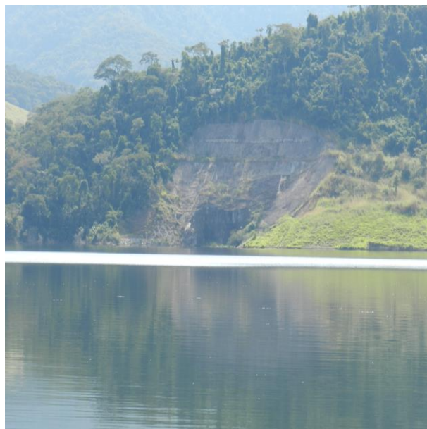
Figura IV-25 – Estação CAL 20, reservatório de Calçado.
