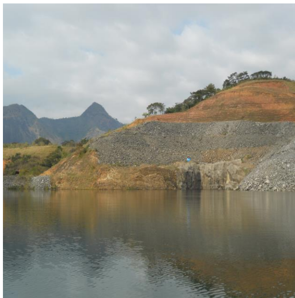
Figura IV-20 – Estação ARE 30, a montante do Dique Louriçal - reservatório de Louriçal.
