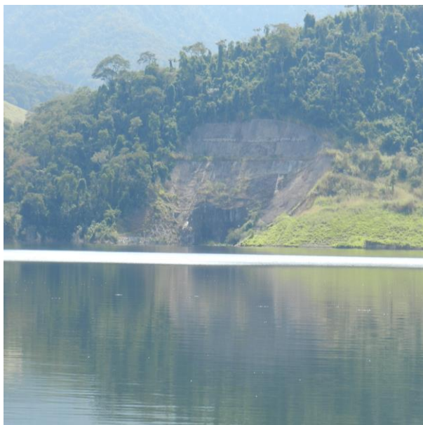
Figura IV-25 – Estação CAL 20, reservatório de Calçado.
