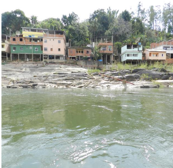
Figura IV-11 – Estação PRB 80, no rio Paraíba do Sul, cidade de Sapucaia/RJ.
