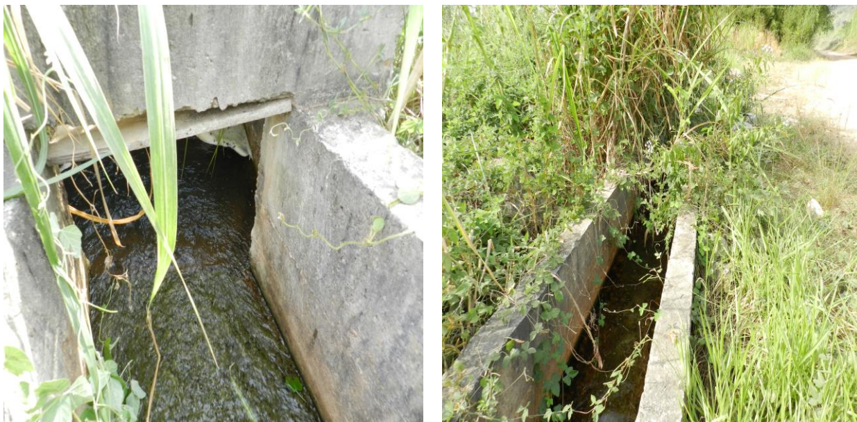
Figura IV-27 – Estação PTR 20, córrego do Prata.
