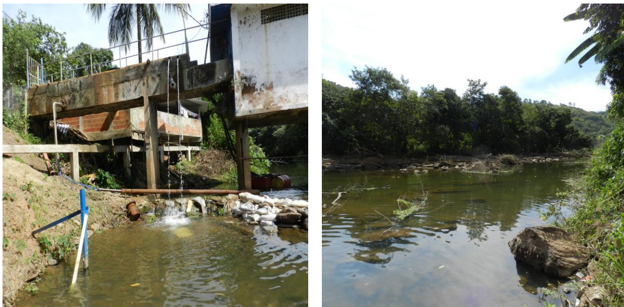
Figura IV-10 – Estação PRB CEDAE, no rio Paraíba do Sul, estação de captação de água da cidade de Sapucaia/RJ.
