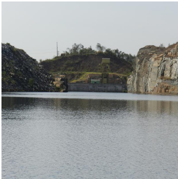
Figura IV-32 – Estação ANT 10, Reservatório de Antonina.
