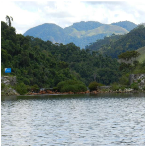
Figura IV-12 – Estação ARE 25, jusante do Dique Alga1 - reservatório de Louriçal.
