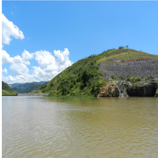
Figura IV-22 – Estação LOU 25, a jusante do Dique Alga2 - reservatório de Louriçal.
