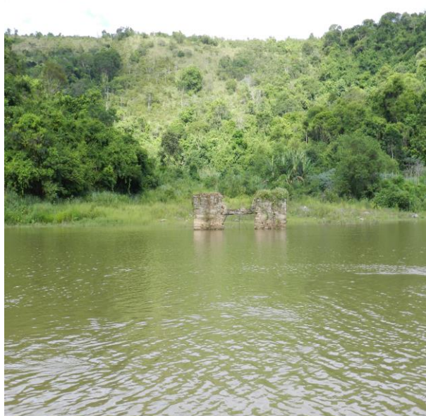
Figura IV-18 – Estação ARE 25, jusante do Dique Alga1 - reservatório de Louriçal.
