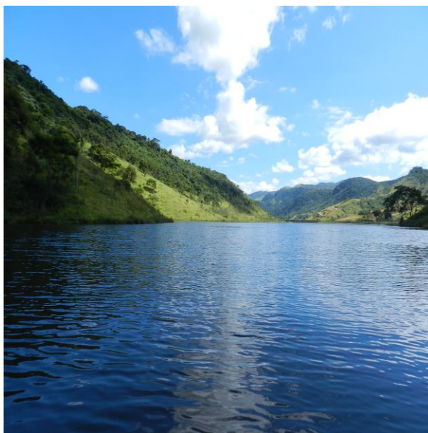
Figura IV-21 – Estação LOU 20, a montante do Dique Alga2 - reservatório de Louriçal.
