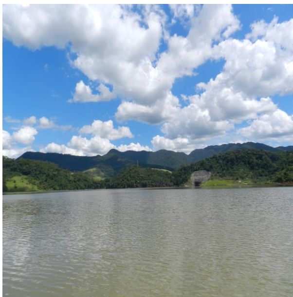
Figura IV-24 – Estação CAL 20, reservatório de Calçado.
