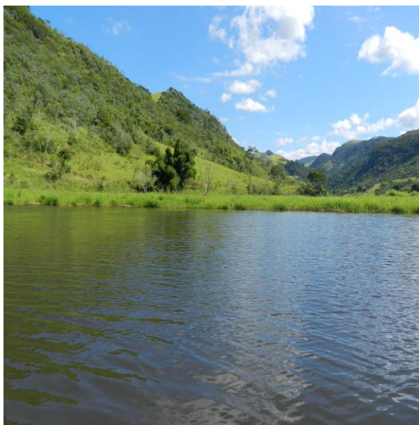
Figura IV-20 – Estação LOU 10, a montante do reservatório de Louriçal.
