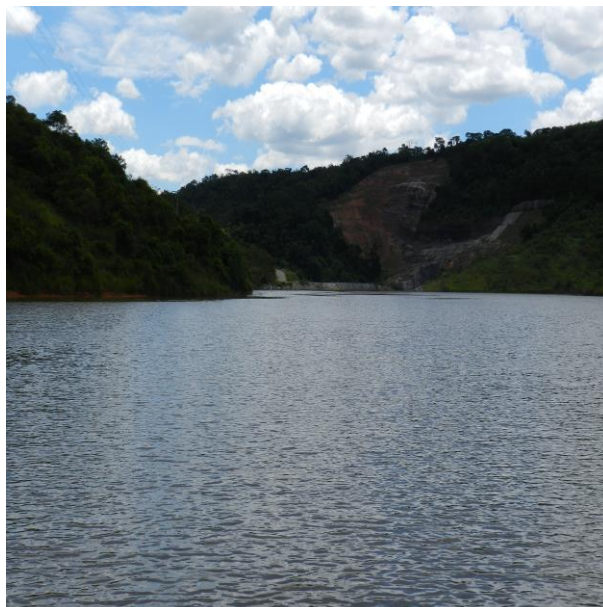
Figura IV-31 – Estação ANT 10, Reservatório de Antonina.
