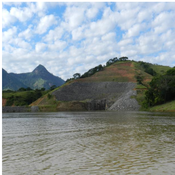
Figura IV-19 – Estação ARE 30, a montante do Dique Louriçal - reservatório de Louriçal.
