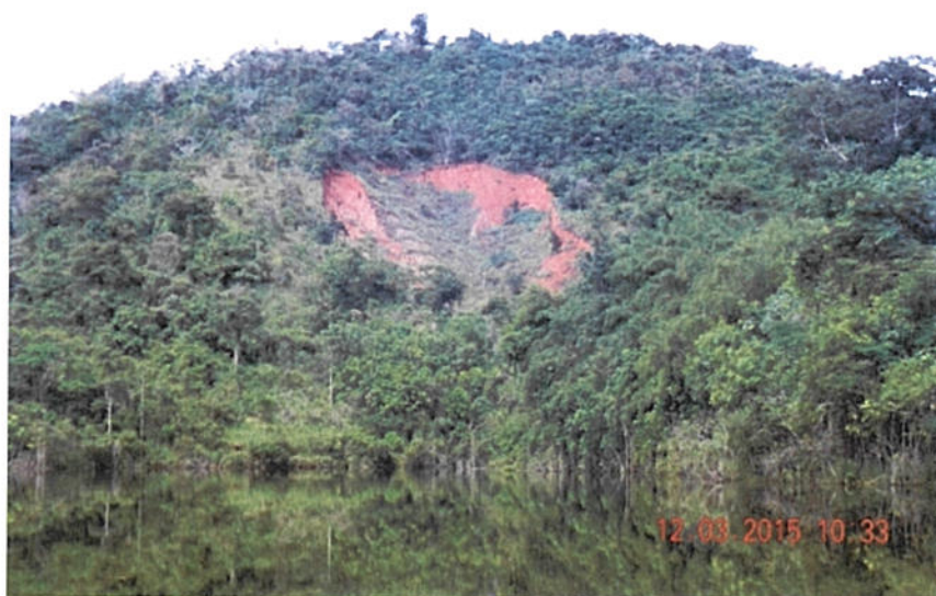
Foto II.2.1.2-2 – Março de 2015 - Vista geral da Erosão 3, embora não houvesse aumento significativo, em sua área de cobertura vegetal, registra-se um adensamento da camada vegetal, aferindo certo grau de estabilidade.
