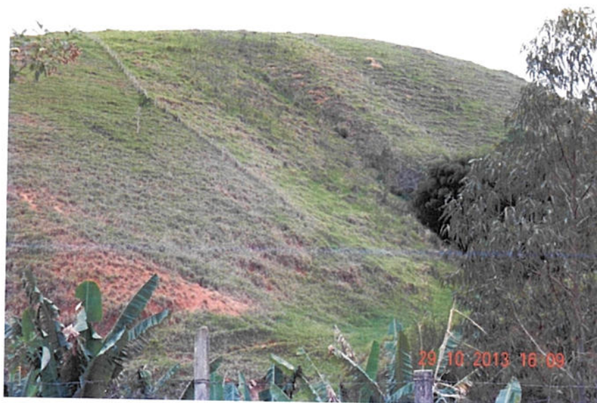
Foto II.2.1.9-1 – Outubro de 2013 – Vista geral da Erosão 10.
