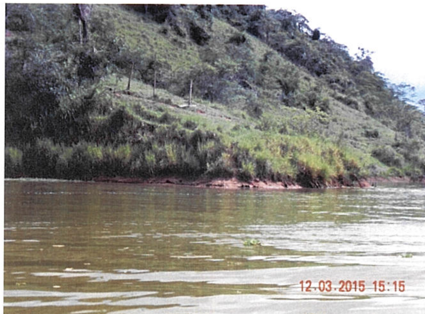
Foto II.2.1.4-2 – Março de 2015 - Vista geral do processo erosivo estabilizado. Observando que a área exposta é referente a amplitude do nível baixo do reservatório.
