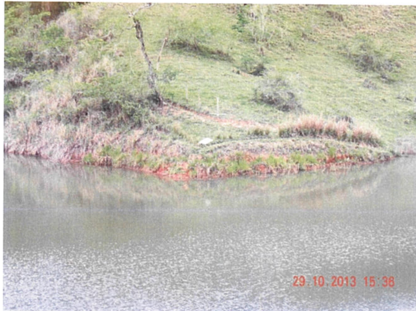
Foto II.2.1.4-1 – Outubro de 2013 - Vista geral do processo erosivo em processo de recuperação da vegetação introduzida.
