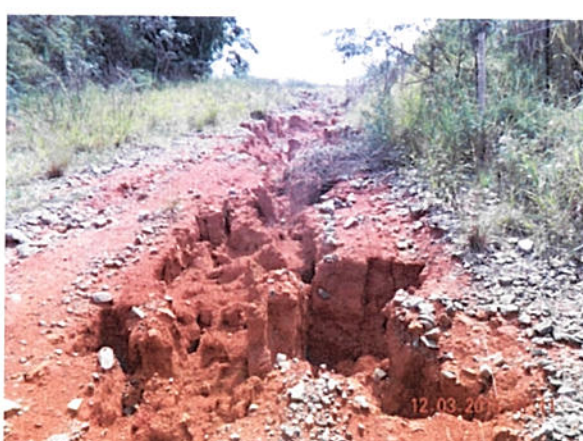
Fotos II.2.1.1-3 e 4: Março de 2015 – Antiga estrada de acesso ao Bota Fora 17, adjacente à Erosão 1. Verifica-se a evolução generalizada dos processos erosivos evoluindo a cada período de chuva com franca tendência ao agravamento do mecanismo e interferência no sítio da Erosão 1.
