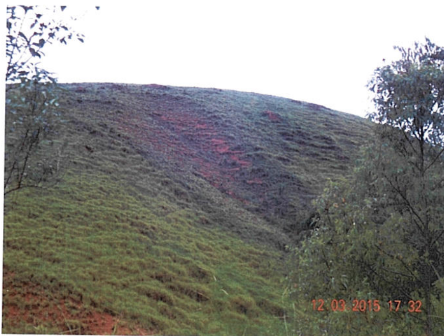
Foto II.2.1.9-2 – Março de 2015 – Vista geral da Erosão 10, onde se constata uma diminuição da população de plantas devido a remoção de cerca.
