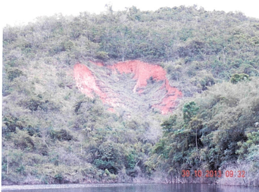
Foto II.2.1.2-1 – Outubro de 2013- Vista geral da Erosão 3, em processo de estabilização.
