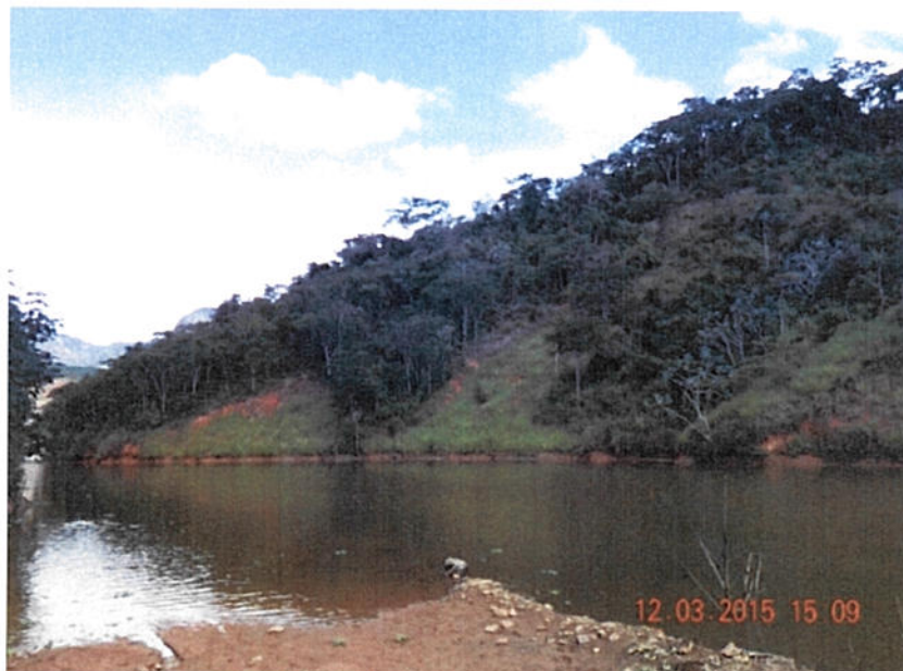
Foto II.2.1.3-1 – Março de 2015 - Vista geral da área após a formação do lago, onde pode ser verificada a estabilização da área de maneira satisfatória, sem evidências de pastoreio.
