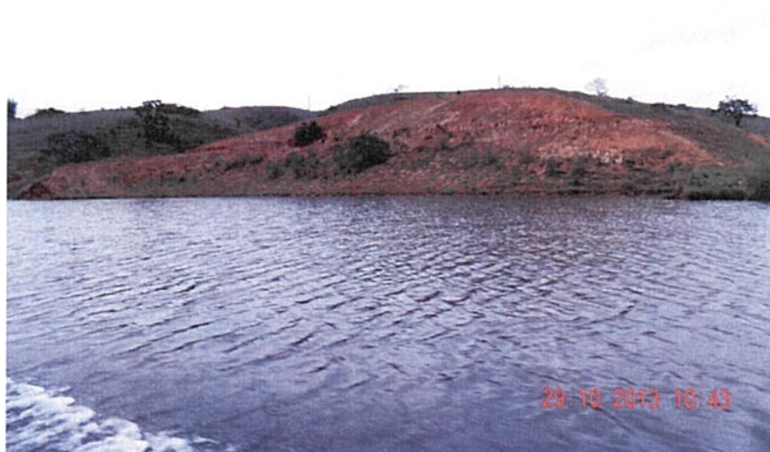
Foto II.2.1.6-1 – Outubro de 2013 – Vista geral da porção exposta da Erosão 7, após o enchimento do reservatório.
