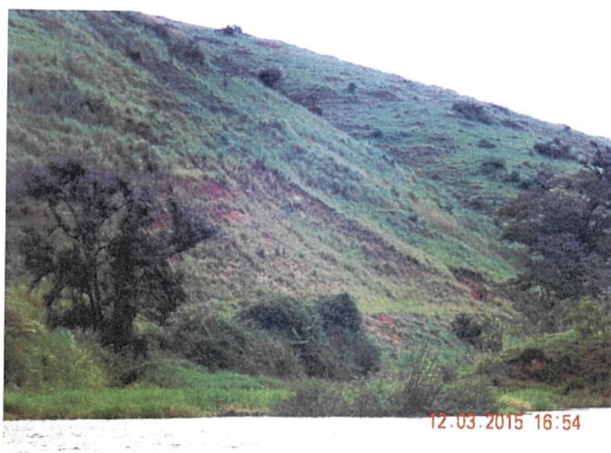
Foto II.2.1.7-2 – Março de 2015 – Vista geral da Erosão 8, parcialmente integrada a paisagem natural.
