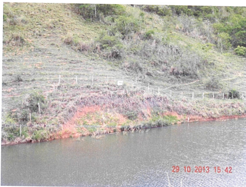
Foto II.2.1.5-1 – Outubro de 2013 - Vista geral do processo erosivo.
