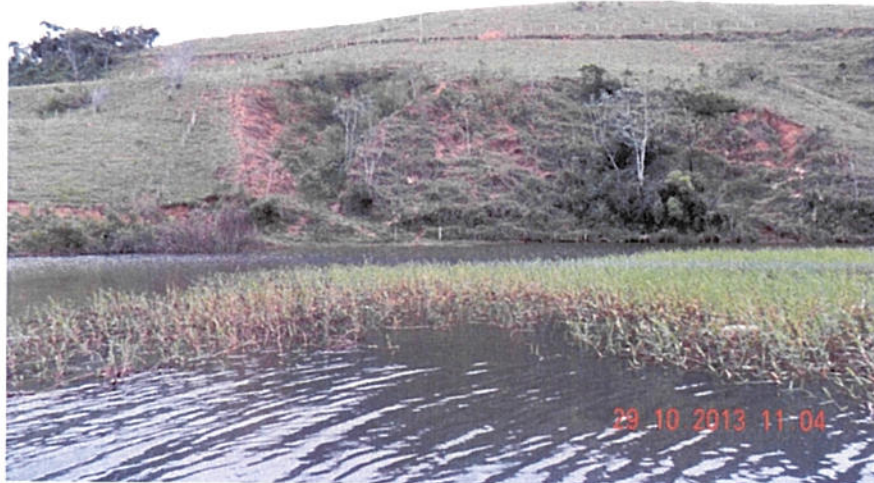
Foto II.2.1.8-1 – Outubro de 2013 – Vista geral da Erosão 9.
