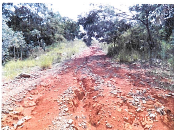
Fotos II.2.1.1-3 e 4: Março de 2015 – Antiga estrada de acesso ao Bota Fora 17, adjacente à Erosão 1. Verifica-se a evolução generalizada dos processos erosivos evoluindo a cada período de chuva com franca tendência ao agravamento do mecanismo e interferência no sítio da Erosão 1.
