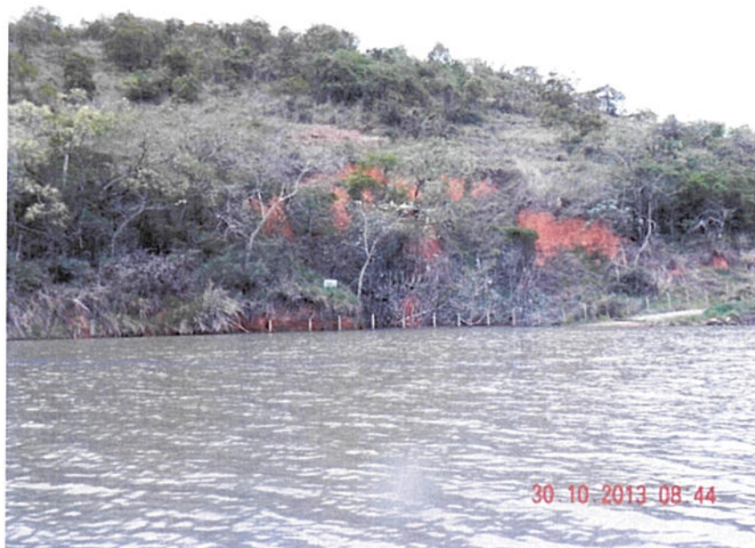
Foto II.2.1.11-1 – Outubro de 2013 – Vista geral Erosão 12.
