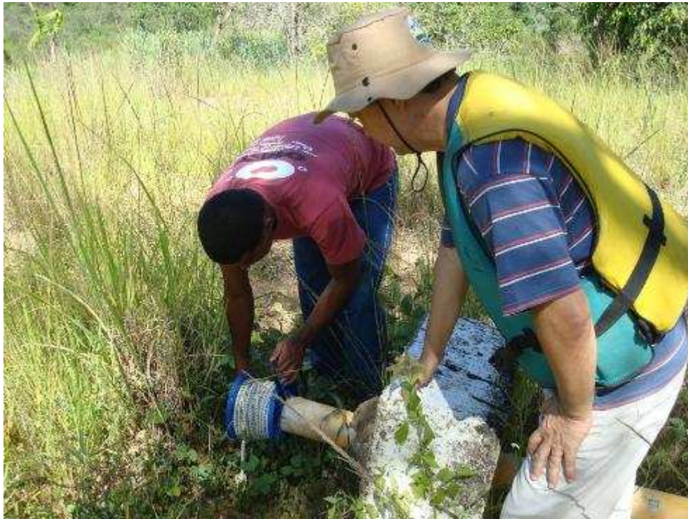
FOTOGRAFIA 19 - Piezômetro PML – 20 - Sítio Campo Alegre – Lixão de Anta – Piezômetro com a tubulação externa arrancada juntamente com a base.
