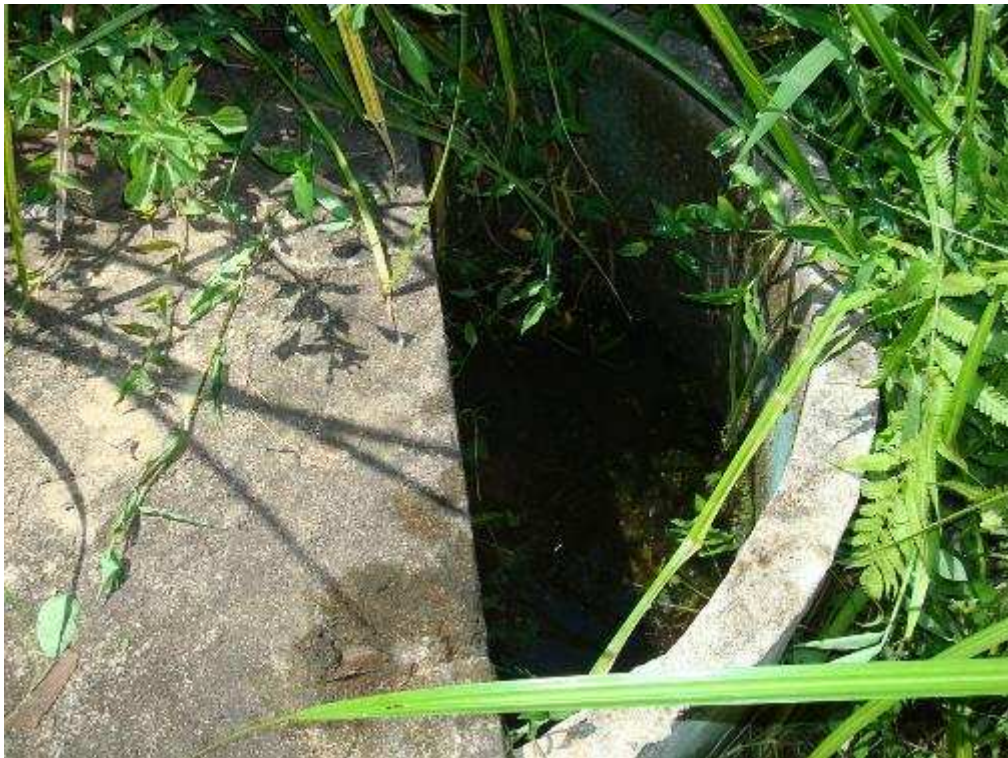
Fotografia 06 - Poço Monitoramento PML – 15. Foto 15/01/2014.
