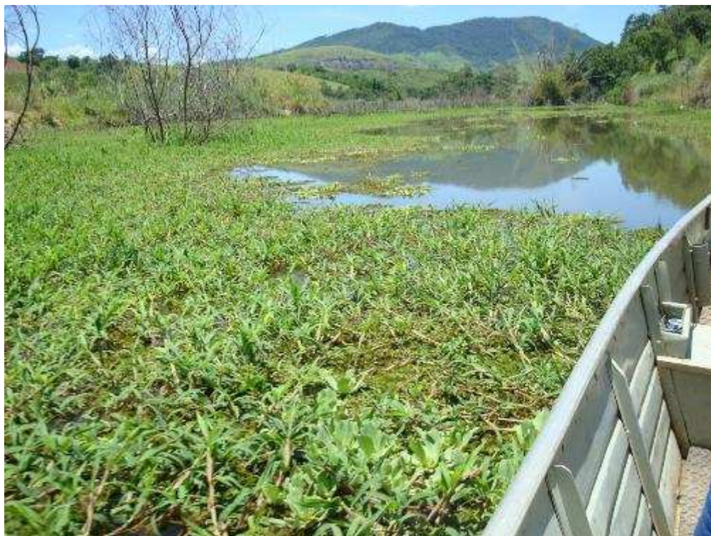
Fotografia 04 – Acesso ao piezômetro PML 07 obstruído por macrófitas. Data: 15/01/14.
