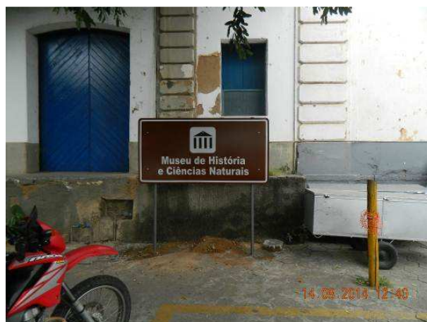
Foto 20.1.3.2-9 - Instalação de placas informativas do programa cultural, Além Paraíba-MG.
