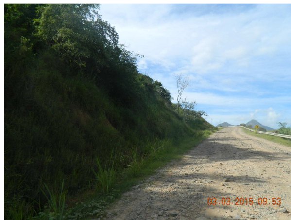
Foto 3.2.4-8 - MG 126 Seg. III, taludes de corte revegetado. Coord. E-713.196; N-7.568.876.
