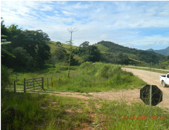
Foto 3.2.4-3 - MG 126 Seg. I, bota fora, reconformado e revegetado. Coord. E-711.976; N-7.570.188.
