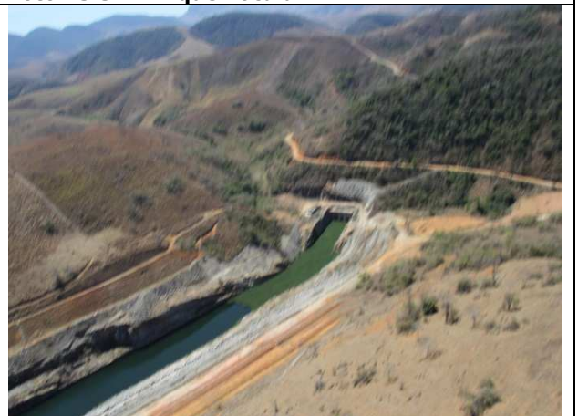
Foto 23.34 – Emboque do Túnel 1
