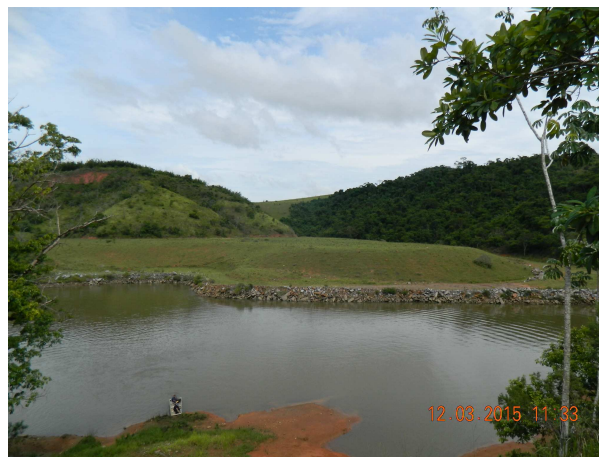
Foto 3.2.1-10 - Bota Fora 16, área restabelecida. Coord. E-711.804; N-7.567.822.
