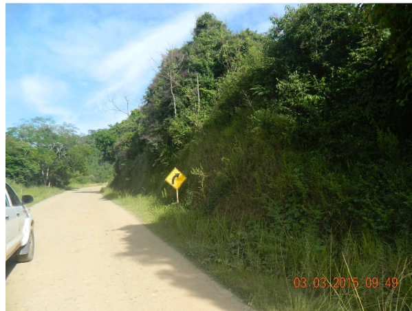
Foto 3.2.4-6 - MG 126 Seg. III, taludes de corte revegetado. Coord. E-713.461; N-7.568.598.
