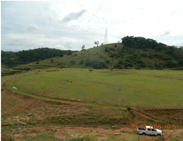
Foto 3.2.1-17 - Bota Fora 5, área restabelecida. Coord. E-707.230; N-7.563.103.
