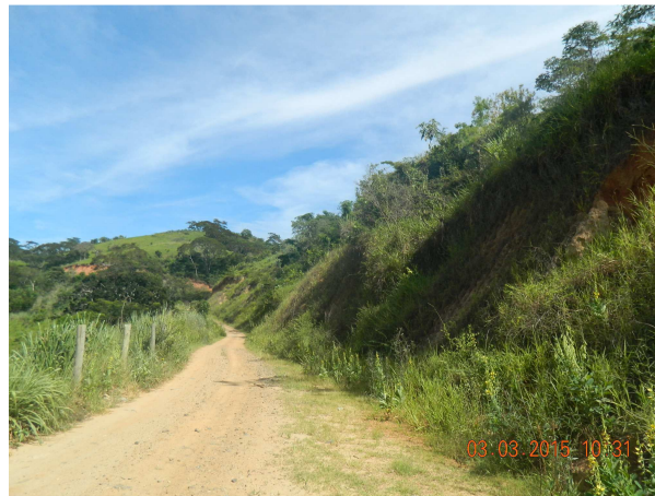
Foto 3.2.4-12 – Acesso Vicinal ACDL, taludes de corte revegetado. Coord. E-712.319; N-7.566.577.
