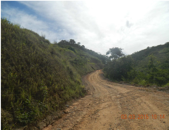
Foto 3.2.4-9 – Acesso vicinal VALP 10, taludes de corte revegetado. Coord. E-713.909; N-7.570.135.
