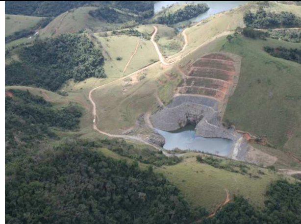
Foto 23.29 – Desemboque do Túnel 2, Canal 4, Dique Louriçal 2 e Emboque do Túnel 2A
