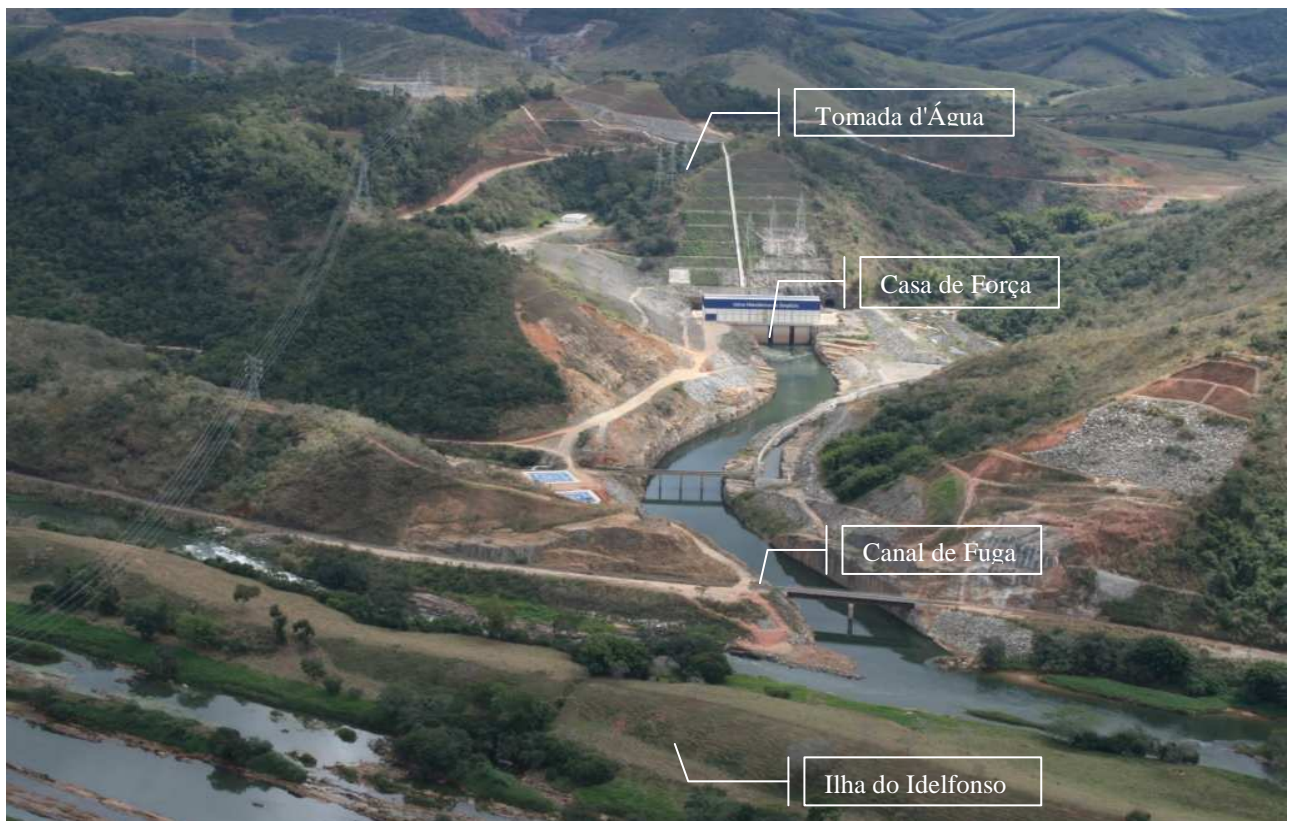
Figura 3 –Casa de Força e Canal de Fuga da UHE Simplício
