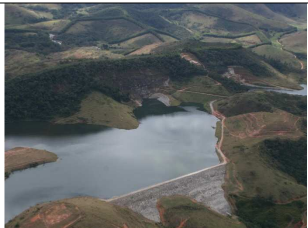
Foto 23.9 - Emboque do Túnel Canal 8
