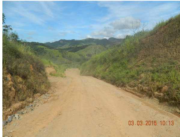
Foto 3.2.4-10 – Acesso vicinal VCH 13, taludes de corte revegetado. Coord. E-713.606; N-7.569.975.
