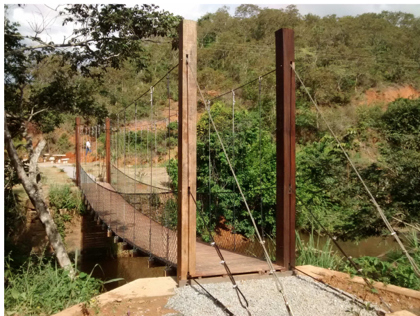
Foto 20.1.3.2-5 – Construção da trilha ecológica em, Além Paraíba-MG.
