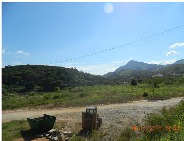
Foto 3.2.1-25 – Canteiro de obras, antiga área de montagem da UHE Anta, reconfirmada e revegetada. Coord. E-706.614; N-7.561.682.
