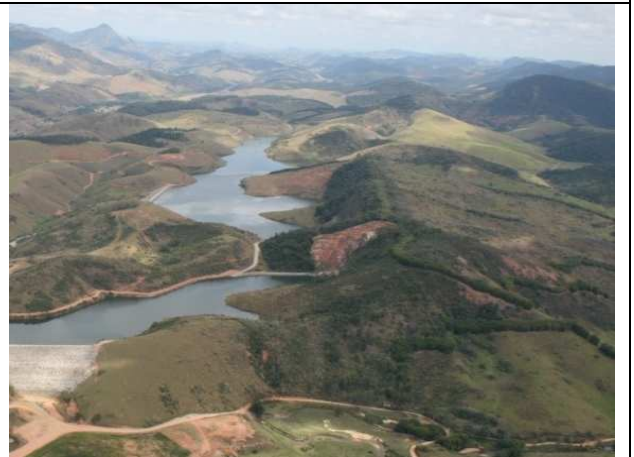
Foto 23.8 – Desemboque do Túnel Canal 8
