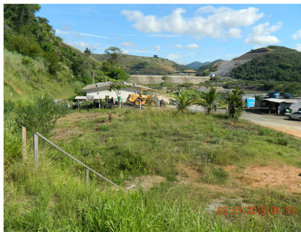
Foto 3.2.1-24 – Canteiro de obras, almoxarifado. Coord. E-706.524; N-7.561.705.
