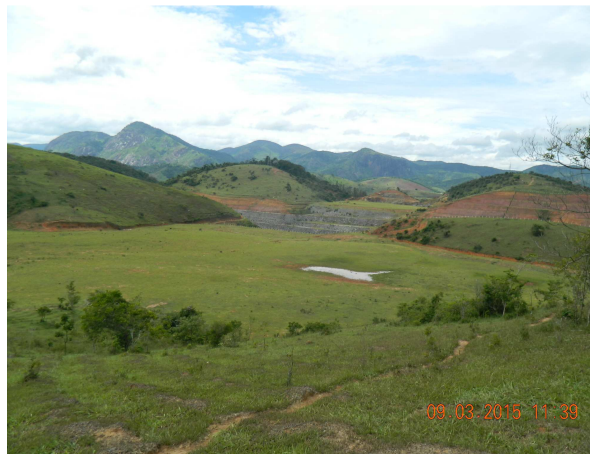
Foto 3.2.1-16 - Bota Fora 6, área restabelecida. Coord. E-706.708; N-7.563.640.
