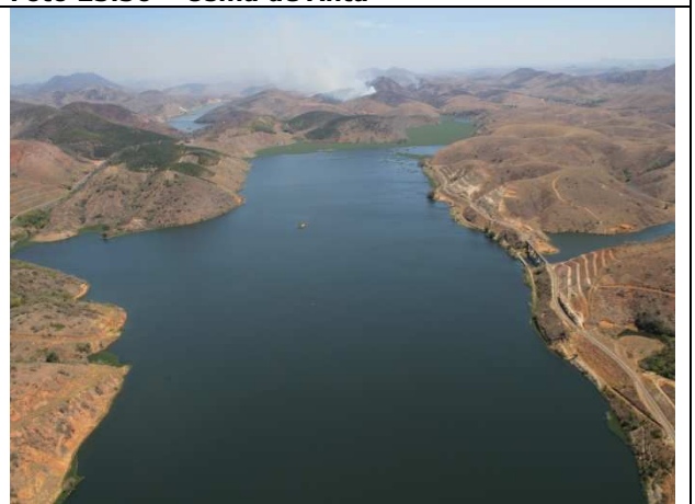
Foto 23.38 – Reservatório de Anta, Próximo ao Início da Relocação da BR 393
