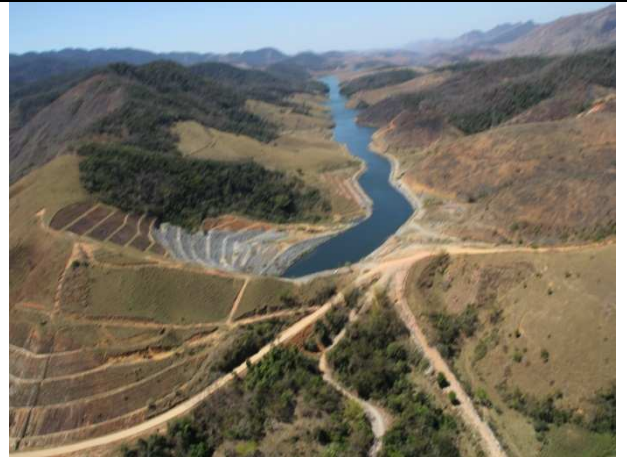
Foto 23.18 – Desemboque do Túnel Canal 5
