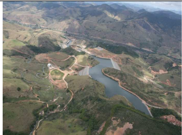
Foto 23.7 – Reservatório de Peixe
