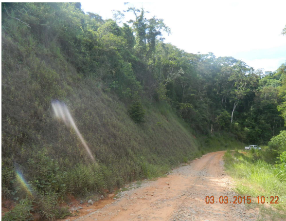
Foto 3.2.4-11 – Acesso Vicinal VCH 09, taludes de corte revegetado. Coord. E-713.122; N-7.567.876.
