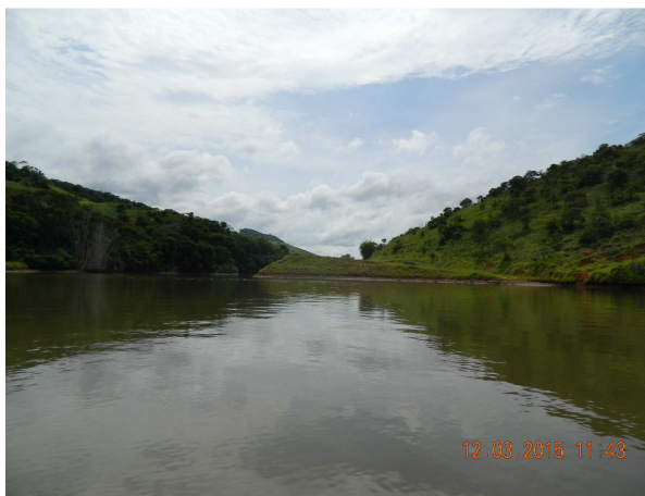
Foto 3.2.1-11 - Bota Fora 15, área restabelecida. Coord. E-712.184; N-7.567.772.
