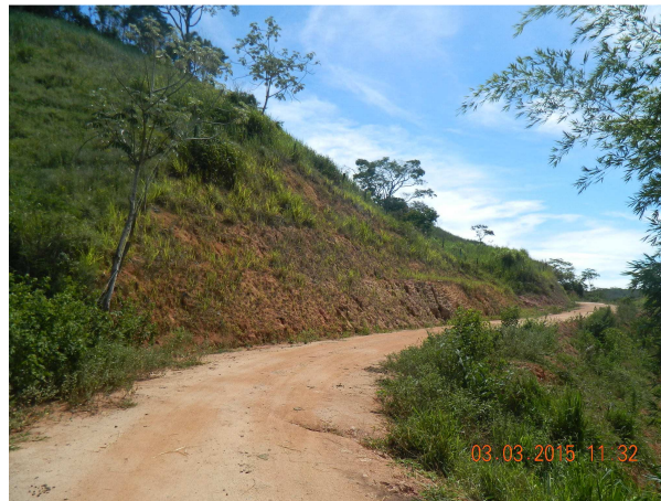
Foto 3.2.4-18 - Acesso vicinal VCH 16, taludes de corte revegetados. Coord. E - 701.654; N - 7.559.414.
