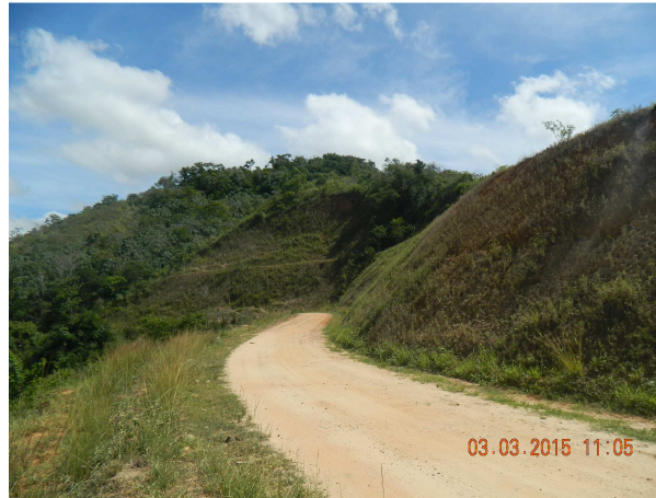
Foto 3.2.4-16 - Acesso Municipal MCH 01, taludes de corte revegetado. Coord. E-703.624; N-7.564.788.
