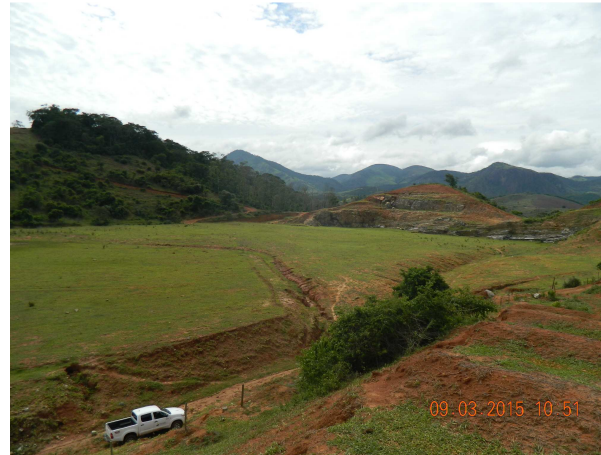
Foto 3.2.1-18 - Bota Fora 5, área restabelecida. Coord. E-707.230; N-7.563.103.
