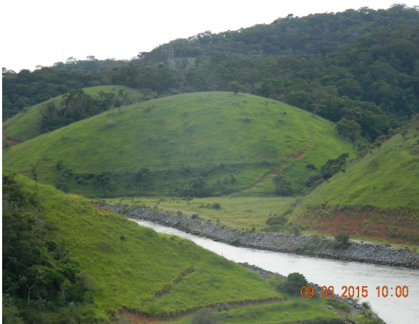
Foto 3.2.1-7 - Bota Fora 20, área restabelecida. Coord. E-714.268; N-7.568.770.
