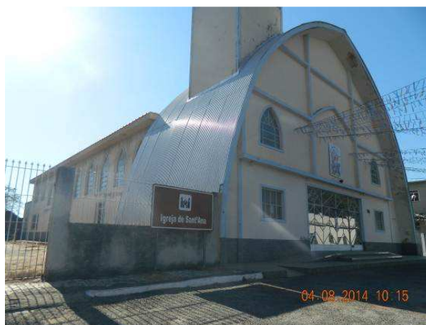
Foto 20.1.3.2-8 - Instalação de placas informativas do programa cultural, Sapucaia-RJ.
