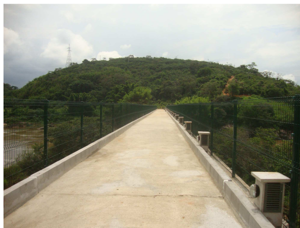
Foto 20.1.3.3-2 – Ponte da ciclovia no distrito de Anta, Sapucaia-RJ.
