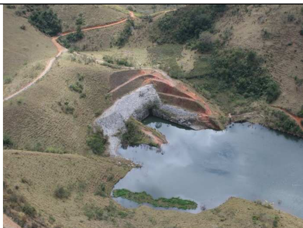
Foto 23.12 – Desemboque do Túnel 3
