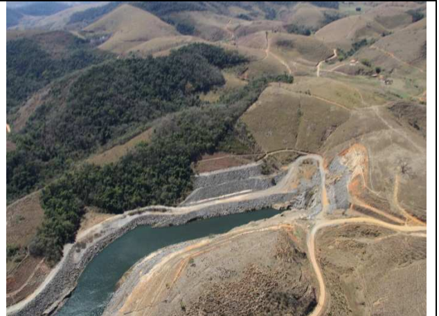
Foto 23.30 – Emboque do Túnel 2
