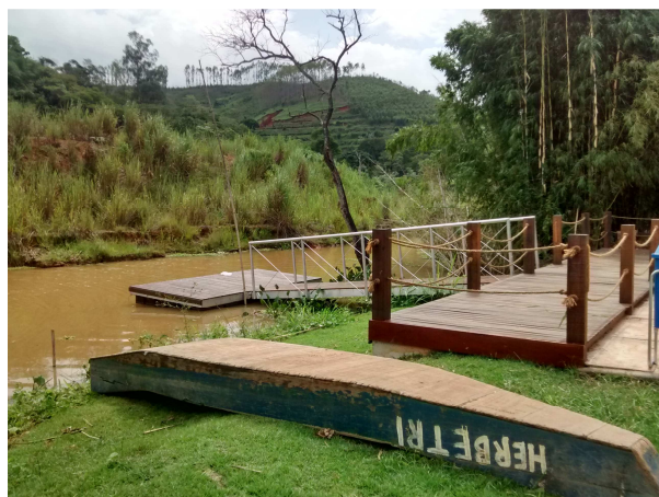
Foto 20.1.3.1-10 – Acoradouro da Cerâmica, município de Três Rios, BR 393.
