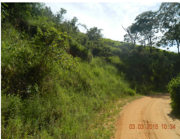
Foto 3.2.4-13 – Acesso Vicinal ACDL, taludes de corte revegetado. Coord. E-711.906; N-7.566.521
