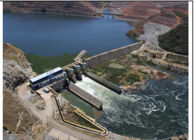
Foto 23.36 – Usina de Anta
