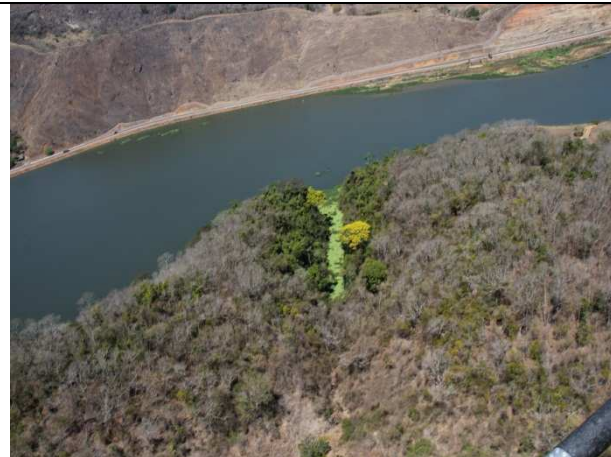
Foto 23.39 – Reservatório de Anta, Próximo ao Início da BR 393
