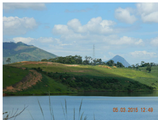
Foto 3.2.1-22 - Área de Empréstimo G, área em restabelecimento, ainda em monitoramento. E - 725.635; N - 7.573.729.
