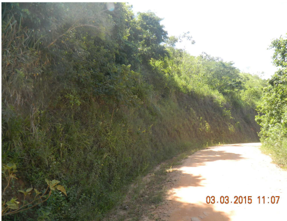
Foto 3.2.4-17 - Acesso Municipal MCH 01, taludes de corte revegetados. Coord. E - 703.222; N - 7.565.073.
