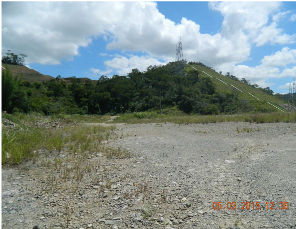
Foto 3.2.1-5 - Bota Fora 34, às margens da UHE Simplício. Coord. E-728.126; N-7.574.051.
