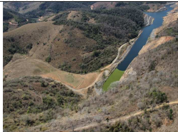
Foto 23.33 – Canal 2 e Desemboque do Túnel 1
