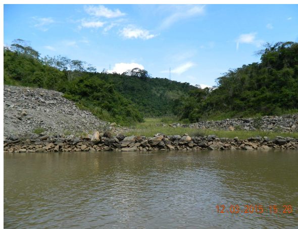
Foto 3.2.1-14 - Bota Fora 8, área restabelecida. Coord. E-708.530; N-7.564.946.
