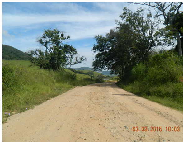
Foto 3.2.4-2 – MG 126 Seg. I, taludes de corte revegetado. Coord. E-711.960; N-7.570.221.
