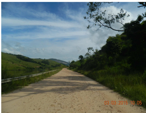
Foto 3.2.4-1 – MG 126 Seg. I, taludes de corte revegetado. Coord. E-711.907; N – 7.570.625.
