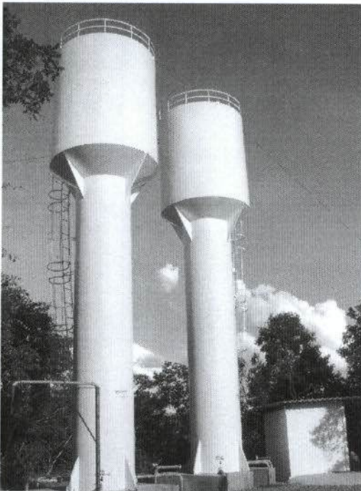
Foto 9 – Caixas d'água para armazenamento de água para consumo humano
