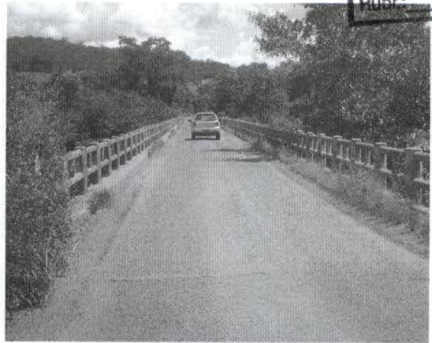
Foto 16 – Ponte a ser deslocada GO 210.
