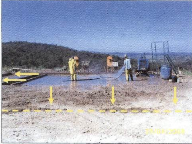
Área impermeabilizada, destinada à lavagem de veículos, que será ampliada para evitar a contaminação do solo ao redor do local.
