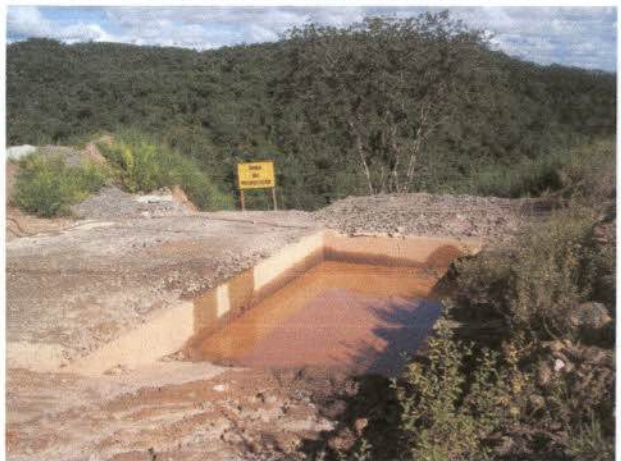
Foto 18 – tanque que recebe a água proveniente do lava - jato
