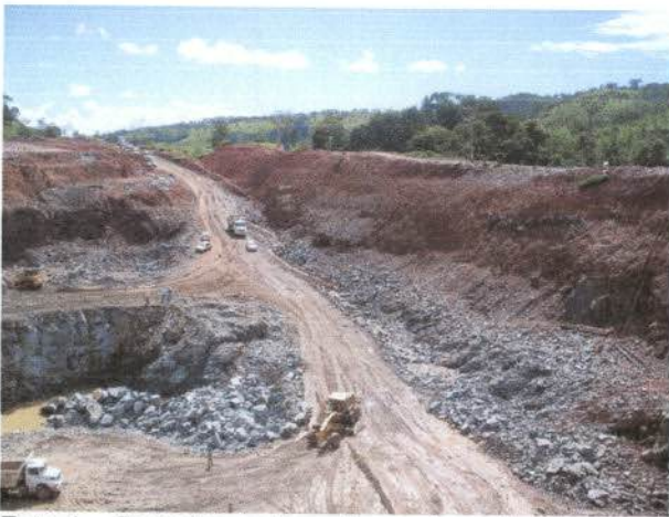
Foto 1 – Pedreira onde está sendo material utilizado na construção da barragem.
