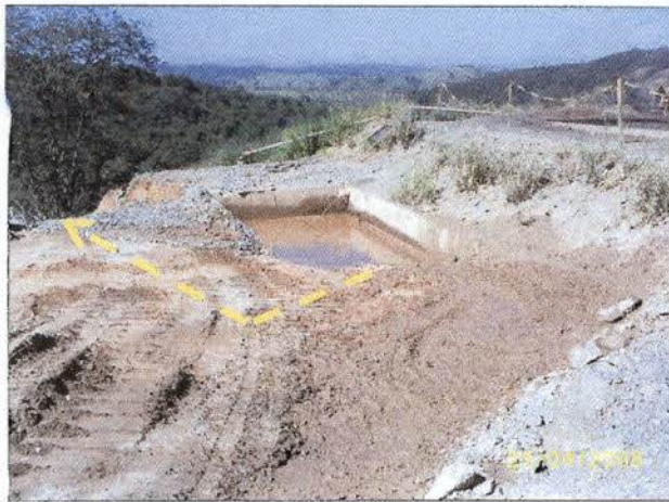
Bacia de decantação que será transferida e ampliada para um melhor funcionamento.
