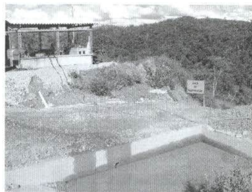
Foto 5 – Área de descarte dos efluentes de lavagem de veículos automotivos
