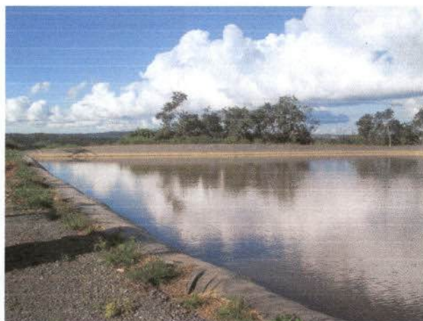
Foto 22 – Depósito de água bruta.
