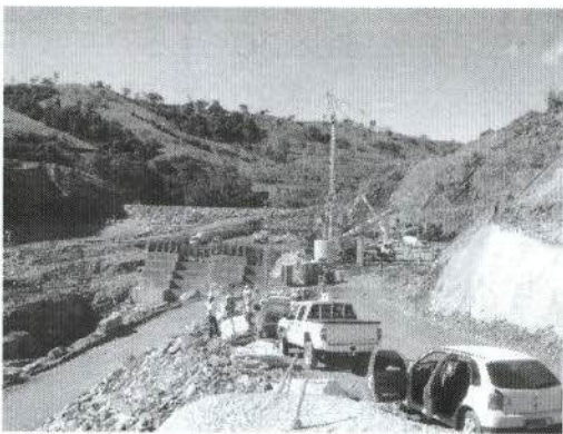
Foto 2 – Obras da barragem
