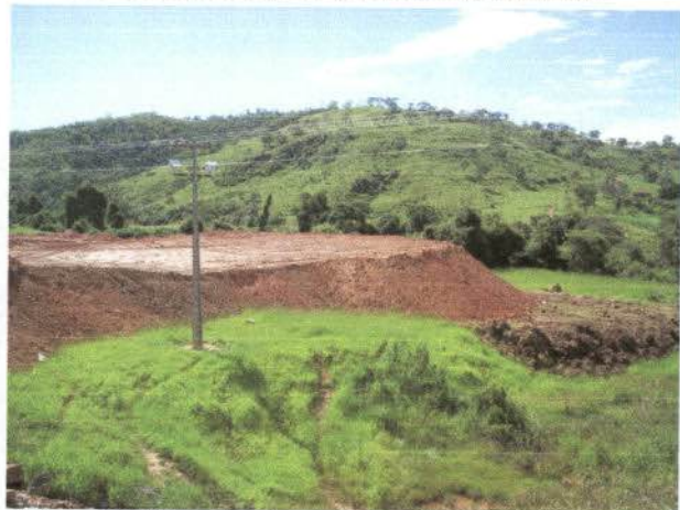
Fotos 4 – Área de deposição de material excedente localizada nas proximidades da pedreira.
