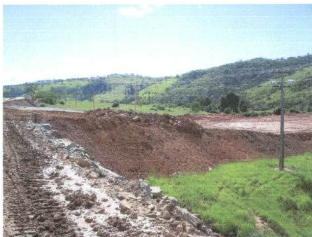
Fotos 5 – Área de deposição de material excedente localizada nas proximidades da pedreira.
