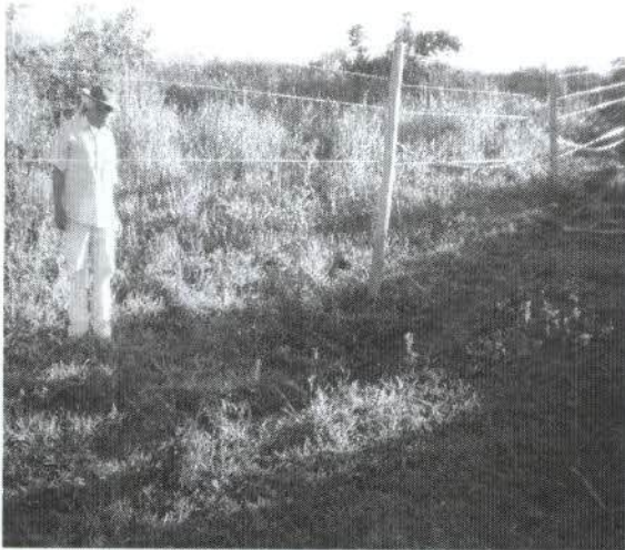
Foto 13 – Cerca danificada Fazenda São Bento.
