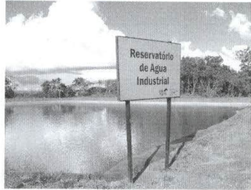
Foto 10 – Tanque de armazenamento de água industrial (piscinão)
