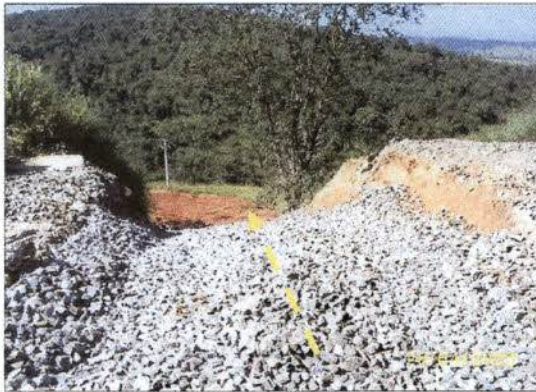
Estrada que dará acesso à caixa separadora de água/óleo e caixa de decantação.
