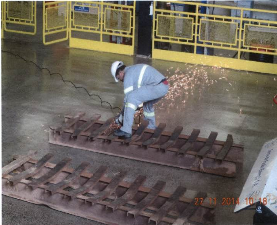
Mata-burro sendo desmontado pelo mecânico da UHE SF.
