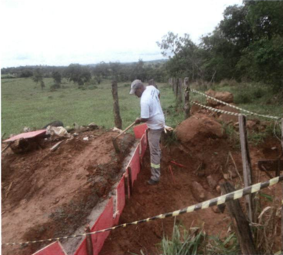
Pessoal da UHE SF construindo a nova base de sustentação para o mata-burro Devidamente restaurado.
