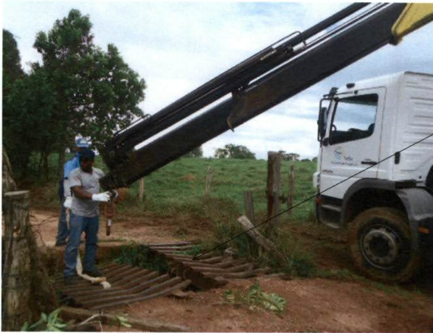
Ação inicial: Remoção do mata-burro danificado da vicinal para a oficina Eletromecânica da UHE SF.
