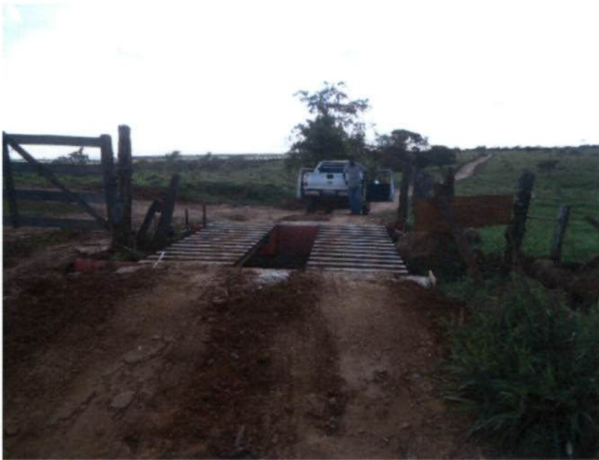
Inspeção final antes de liberar o mata-burro para tráfego.
