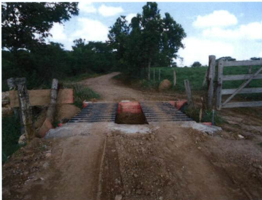
Mata-burro reposto na vicinal após restauração e em condições normais de uso.
