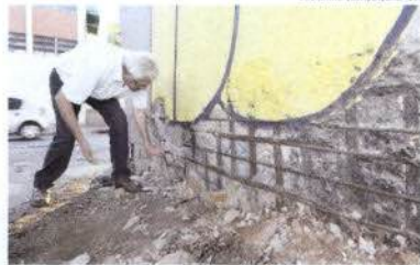
Ferragens expostas no viaduto do Extra: em um ano, quadro só piorou
