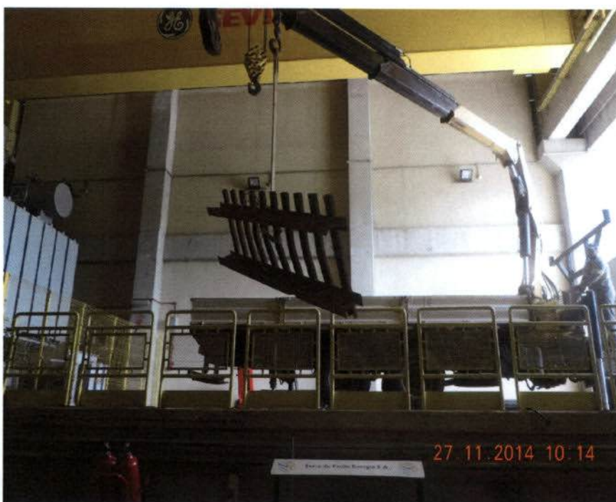
Mata-burro sendo descarregado na área de serviço da UHE SF.
