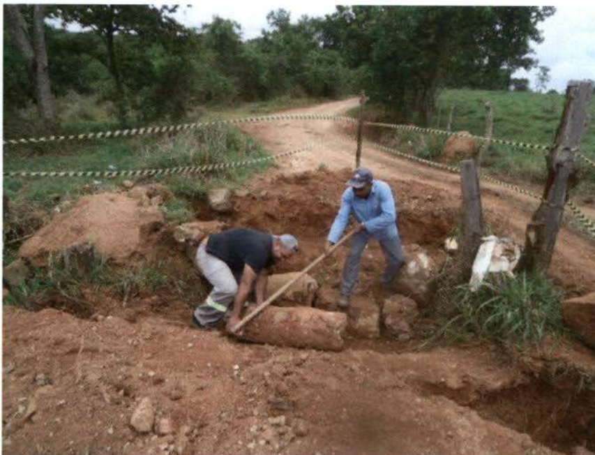
Desmontagem e remoção da base de sustentação do mata-burro danificado.
