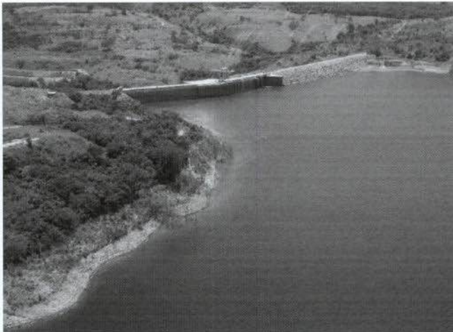
Figura 09: Presença de ondulações da lâmina d'água provocadas por vento nas proximidades do eixo do barramento da UHE Serra do Facão.
