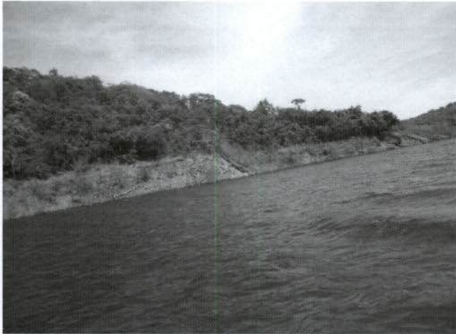
Figura 25: Erosão ERN 01. Lateral esquerda com outros pequenos focos erosivos.
