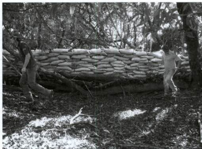
Figura 23: Interior da erosão E 42 com barreira de solo/cimento sobre paliçada.
