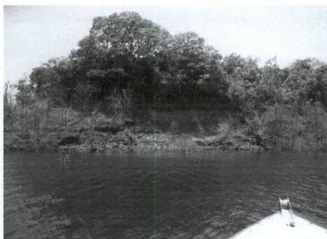
Figura 17: Erosão ERN 04 sob cobertura florestal. Área de paliteiro.
