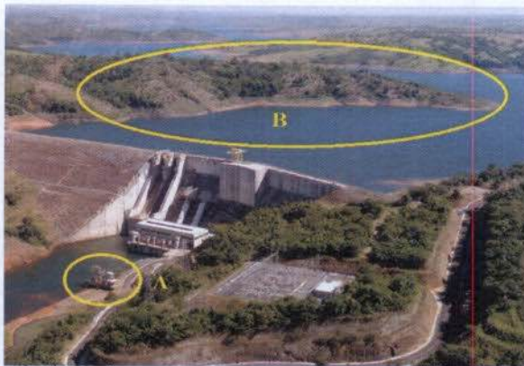
Foto 09: UHE Serra do Facão, sendo possível observar o STP (A) e a Área 1 de Monitoramento da APP (B).
