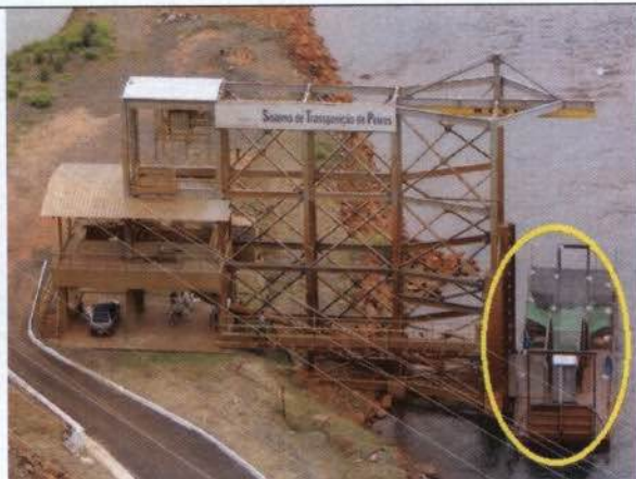
Foto 01: Sistema de Transposição de Peixes (STP), com destaque à estrutura flutuante.
