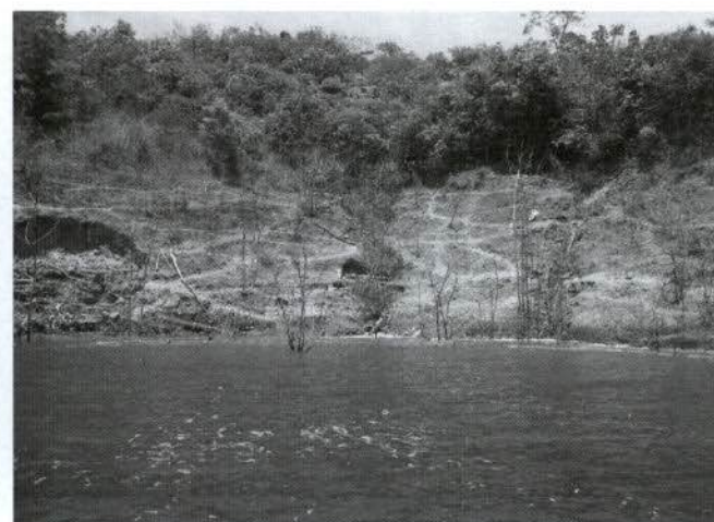
Figura 18: Erosão ERN 04, lateral esquerda com outros pequenos focos (sulcos).
