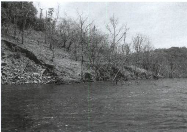
Figura 27: Erosão ERN 01. Lateral direita com outros pequenos focos erosivos em evolução e presença de paliteiros.
