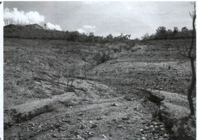
Figura 39: Loteamento próximo à ponte dos carpinas com corte e aterro irregular já mostrando sulcos erosivos.
