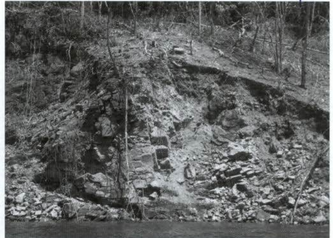
Figura 26: Erosão ERN 01. Presença de piquetes de monitoramento na cabeceira.
