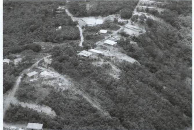
Figura 34: Loteamento irregular com desmatamento e aterro em encostas.
