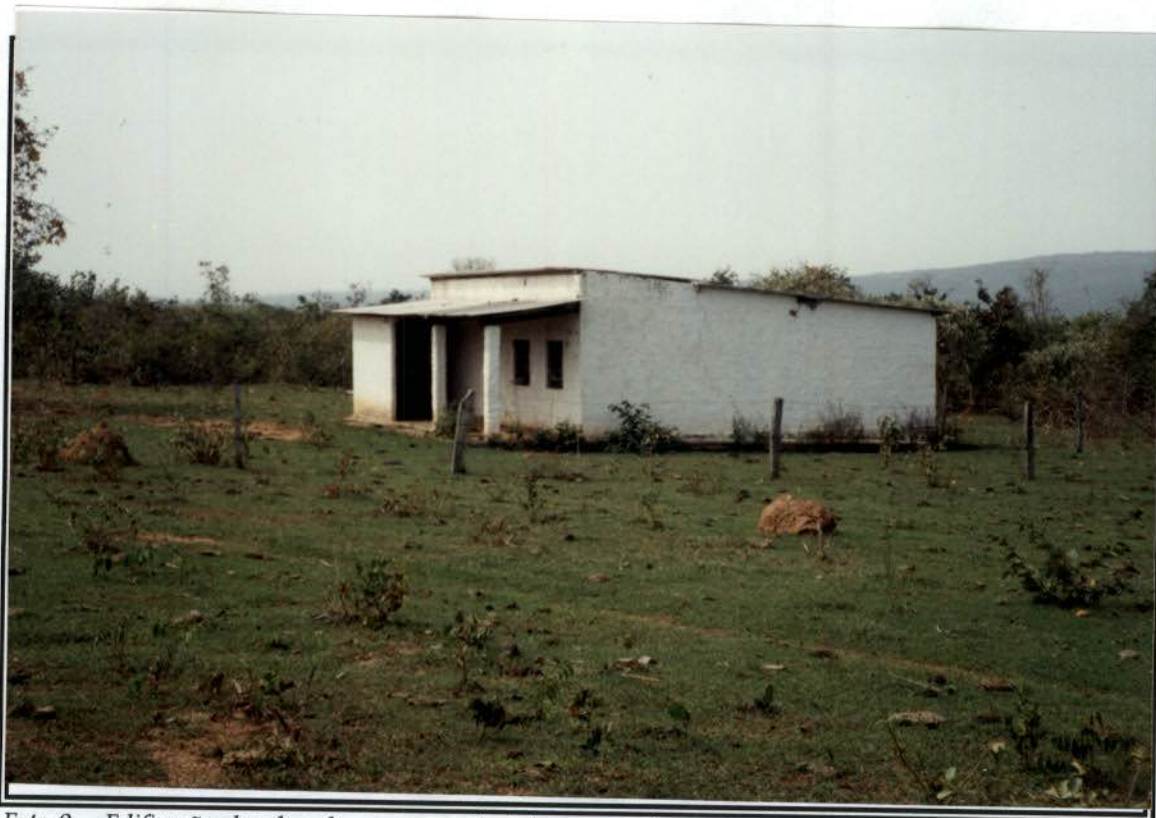
Foto 9 - Edificação abandonada, que segundo informações de representante do Consórcio, abrigava núcleo escolar.
