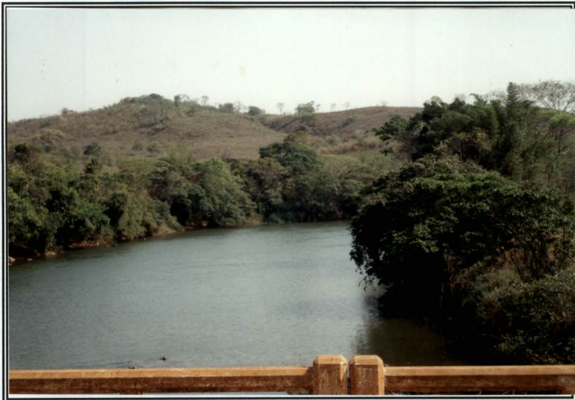
Foto 5 - Vista, do alto da ponte sobre o rio São Marcos. Observar vegetação de APP em bom estado de conservação.
