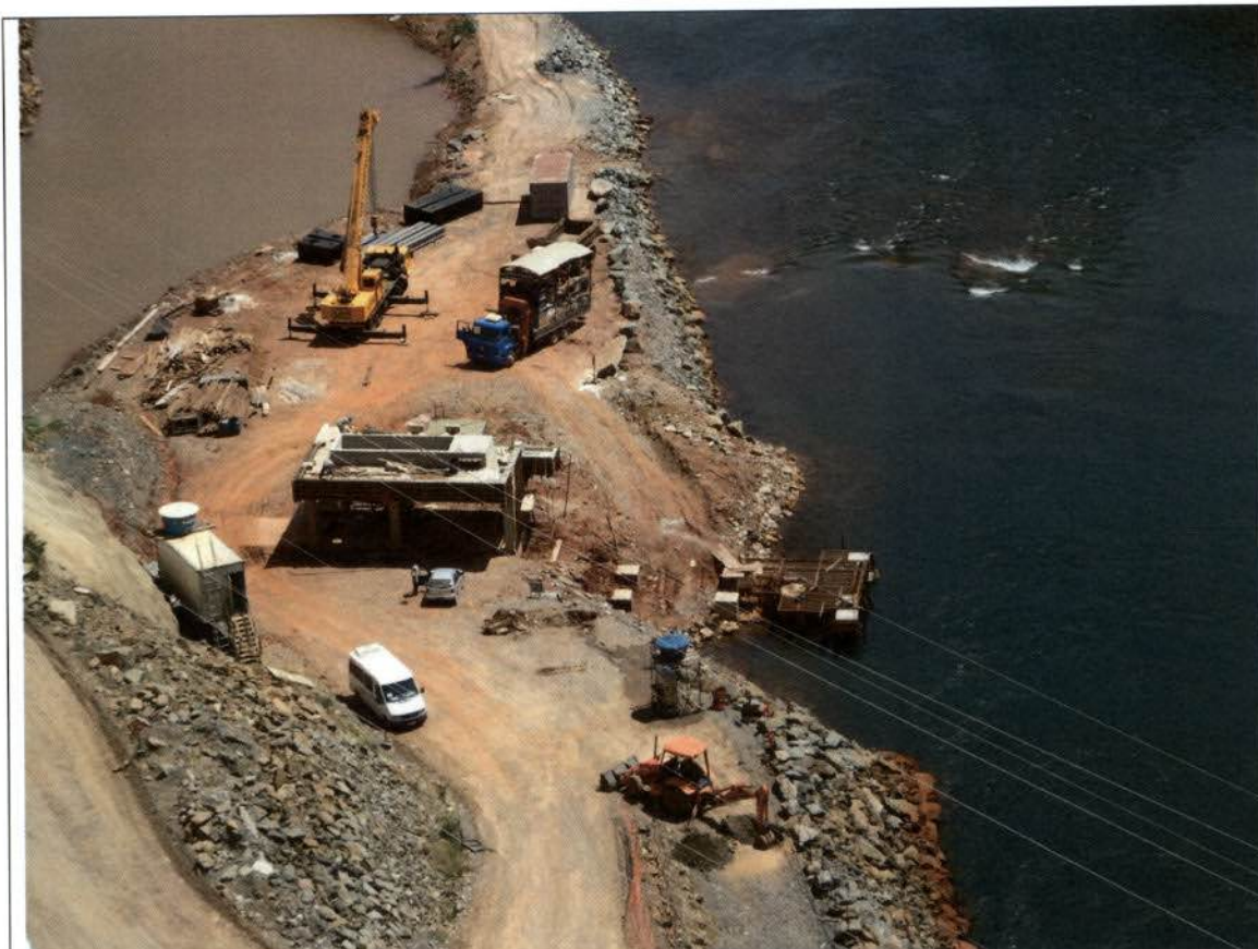
Localização do Edifício de Triagem a jusante do Barramento – Vista de Montante
