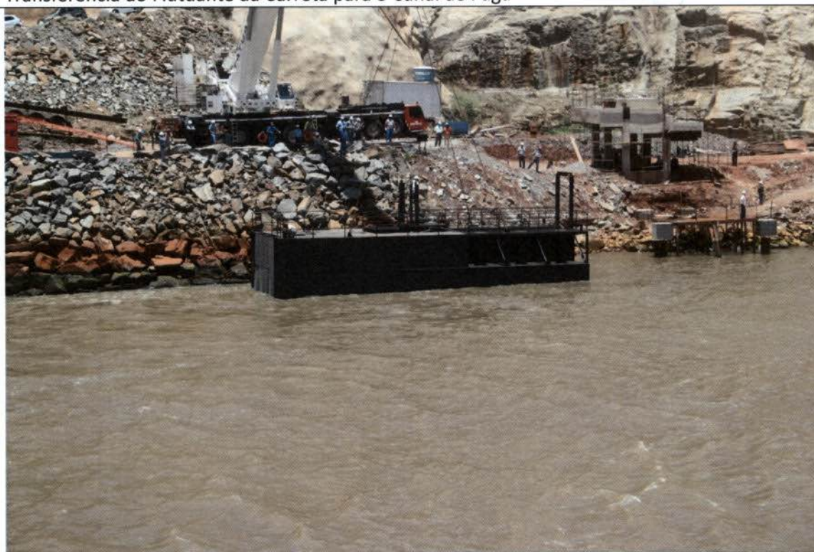
Flutuante já na água antes do aumento da vazão turbinada a jusante
