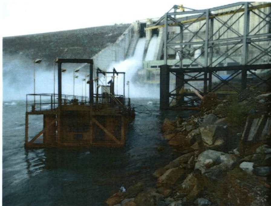
Foto1: Flutuante ancorado a jusante do edifício de triagem com vertimento ao fundo.
