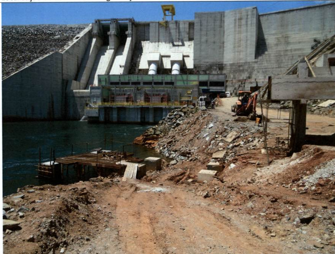
Localização do Edifício de Triagem a jusante do Barramento – Vista de Jusante
