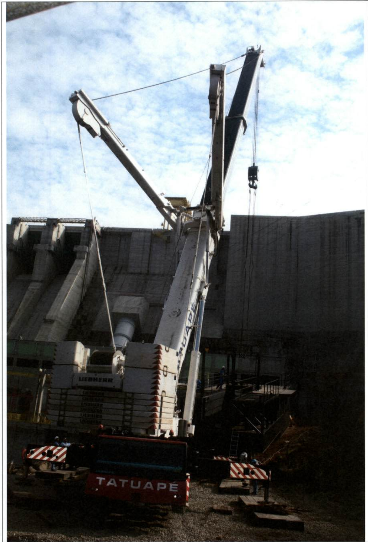
Guindaste utilizado para colocar o Flutuante na água – canal de fuga
