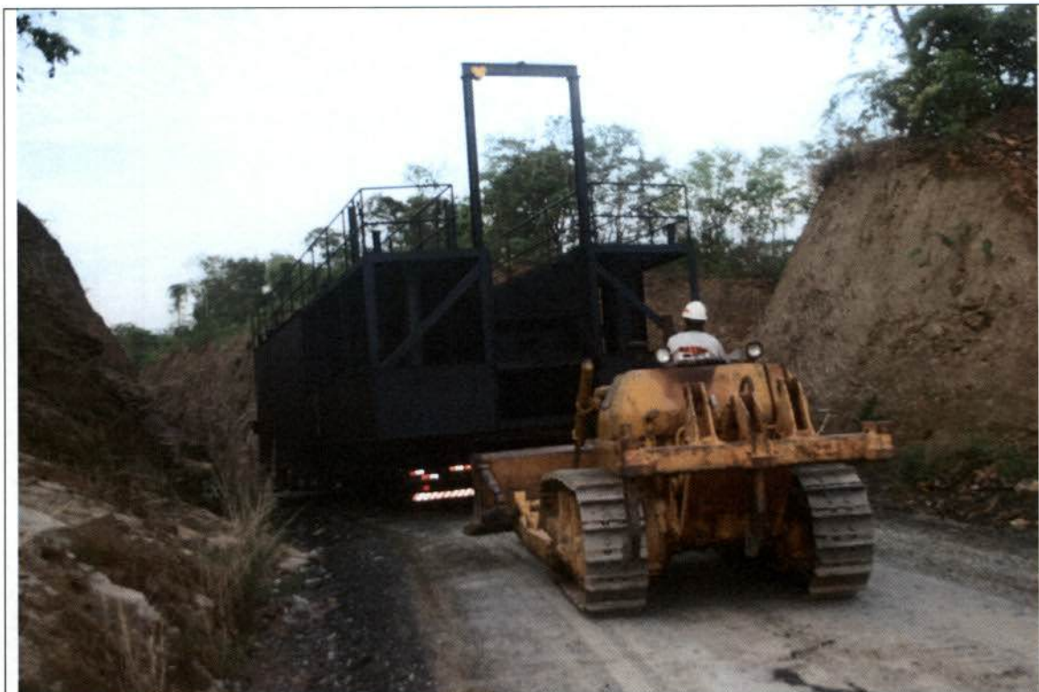
Acompanhamento da descida do flutuante até a parte a jusante do Barramento
