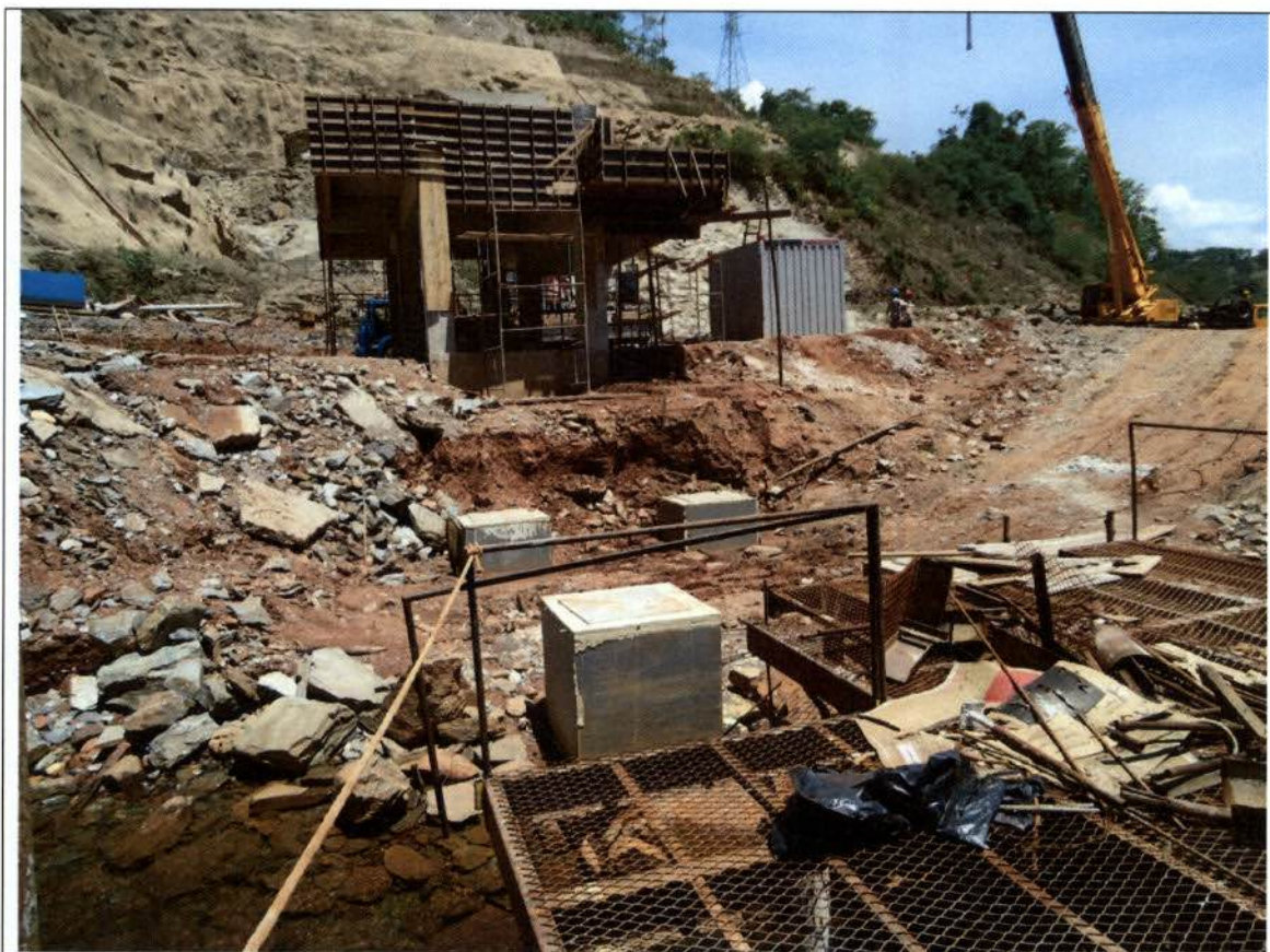
Edifício de Triagem em construção
