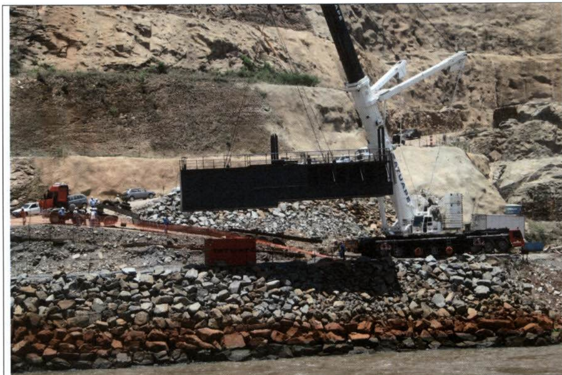
Transferência do Flutuante da Carreta para o Canal de Fuga
