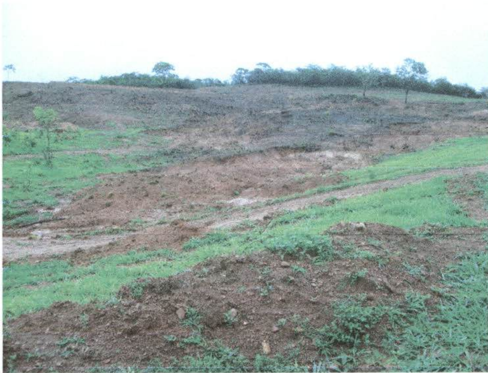
Foto 1.3 – Enterrio do material lenhoso na área a ser inundada.
