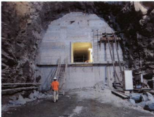
Foto 13: Área onde foi feita a concretagem de segurança do túnel de desvio do rio, após o fechamento de suas comportas para o enchimento do reservatório.
