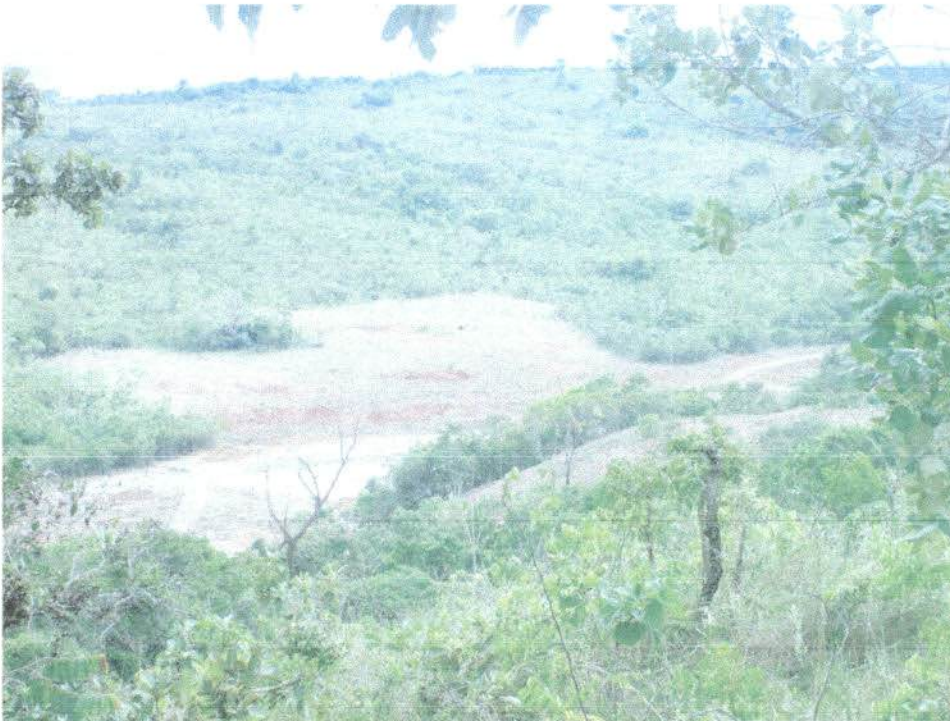
Foto 1.22 – Desmate e destinação concluídos.
