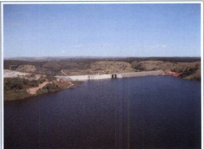
Foto 02: Visão do reservatório no eixo da barragem.
