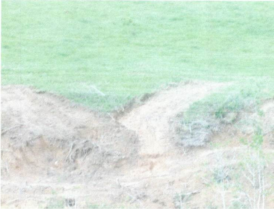
Foto 1.21 – Material lenhoso enterrado na área a ser inundada.
