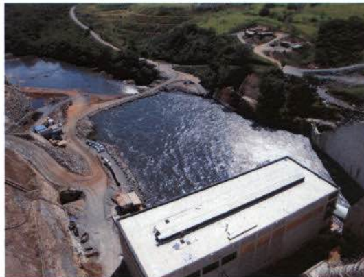
Foto 8: Casa de força e bacia de dissipação (jusante).
