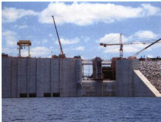
Foto 7: Barragem da UHE Serra do Facão vista de montante. Detalhe dos dois vertedouros (quadrante direito) e no quadrante inferior esquerdo as quatro comportas (em preto) da tomada d'água. Na parte superior das referidas comportas fica o NA mínimo de operação.
