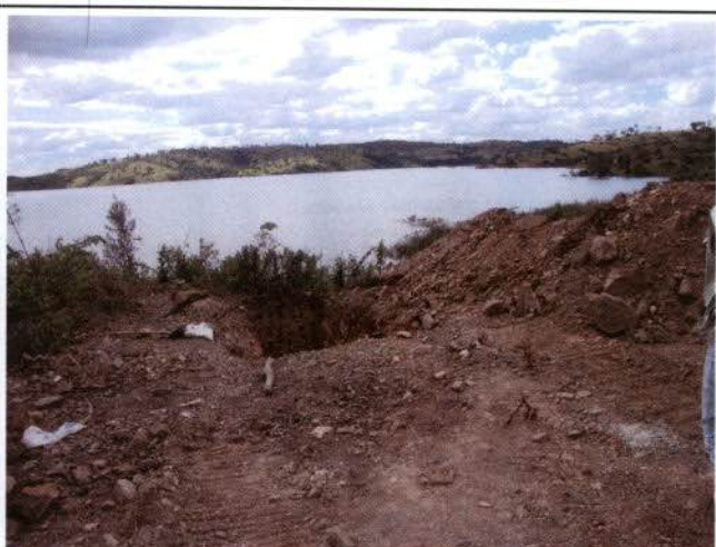
Foto 18: Vala cavada para enterrios dos espécimens coletados próximo ao porto – canteiro de obra.
