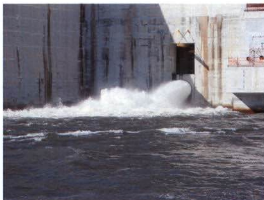
Foto 9: Válvula de vazão residual em operação. Esta válvula mantém o escoamento do rio.
