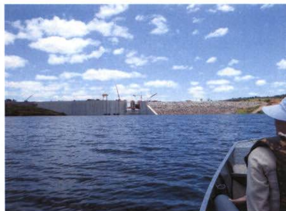
Foto 6: Barragem da UHE Serra do Facão vista de montante.
