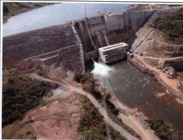
Foto 16: Vazão sanitária de 20 m 3 /s na UHE Serra do Facão.
