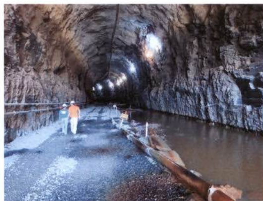
Foto 12: Interior do túnel de desvio do rio.
