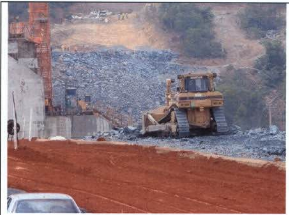
Foto 7 - Trator trabalhando no enrocamento da barragem.
