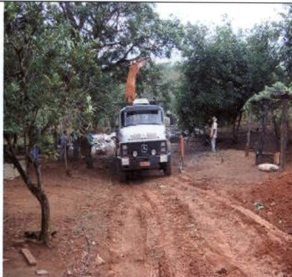
Foto 45 - Processo de demolição, desinfecção e desinfestação na propriedade do Sr. Felinto.
