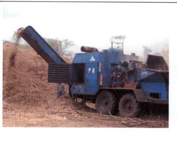
Foto 29 - Operação de trituração de resíduos de desmate
