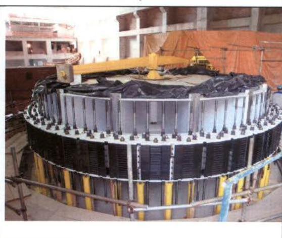
Foto 4 - Montagem da parte elétrica da unidade geradora 1.
