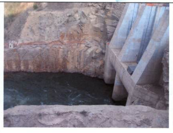
Foto 8 - Entrada do canal de desvio do rio.
