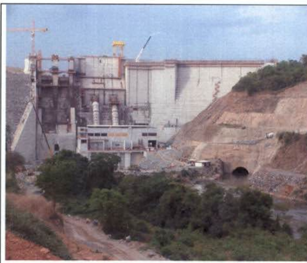
Foto 1 – Vista geral das obras da represa.
