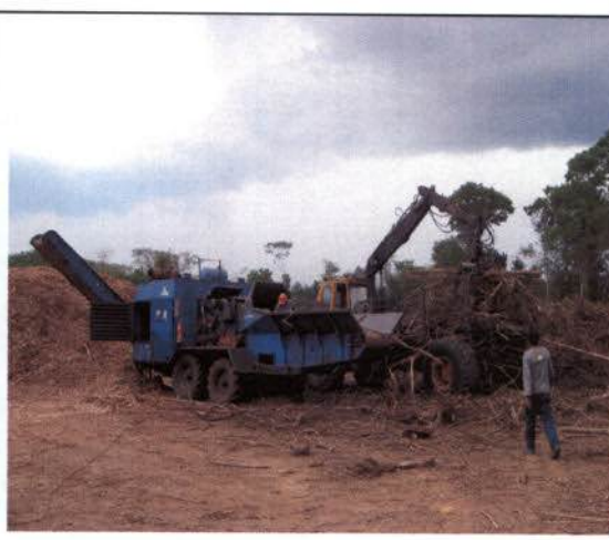
Foto 28 - Operação de trituração de resíduos de desmate
