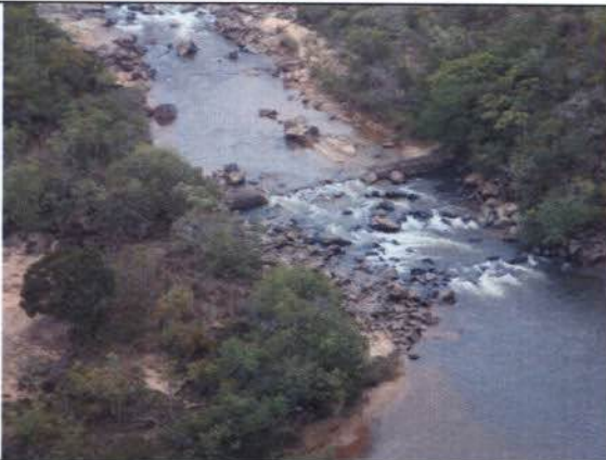
Foto 35 - Barragem velha descomissionada no rio São bento.
