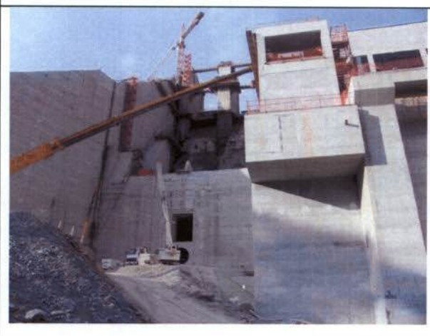
Foto 3 – Área do vertedouro e da válvula de vazão residual.
