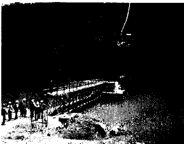
Obra da Ponte do Carapina
