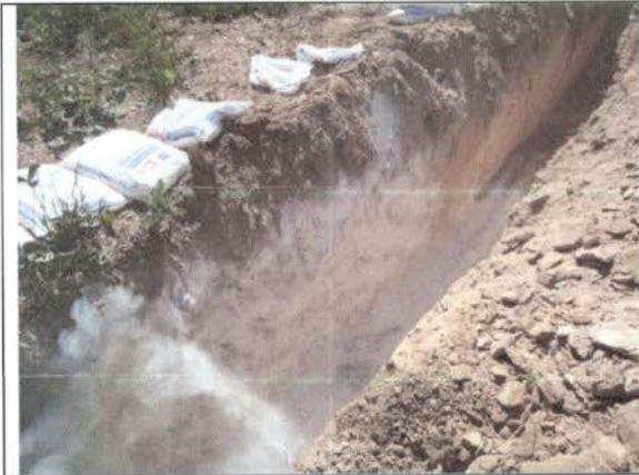
Preparo da vala para o descarte dos peixes.
