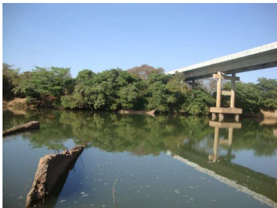
Foto 23: Visão geral do ponto ALM 30 (ago./10).
