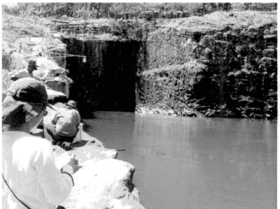
Foto 3 - Ao fundo local de saída da água que passa pelas turbinas da usina hidrelétrica de Serra da Mesa. Registro de dados na estação MRN-55.
