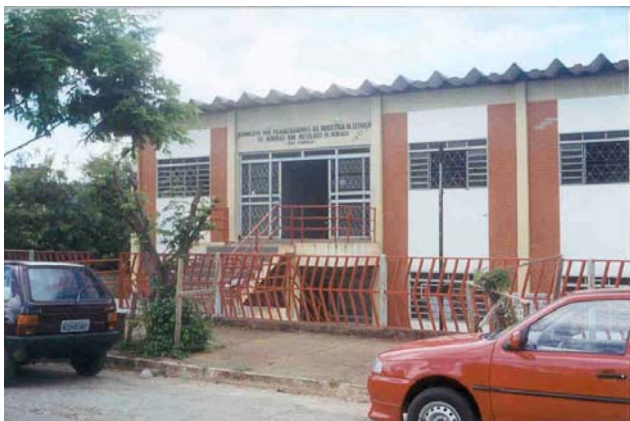
Figura 10.11 Sede do Sindicato Indústria da Extração de Minerais não Metálicos
