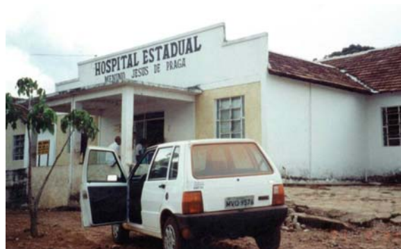
Figura 3.25 Hospital de Paranã
