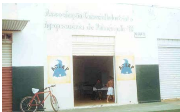
Figura 10.7 Sede da ACIAP
