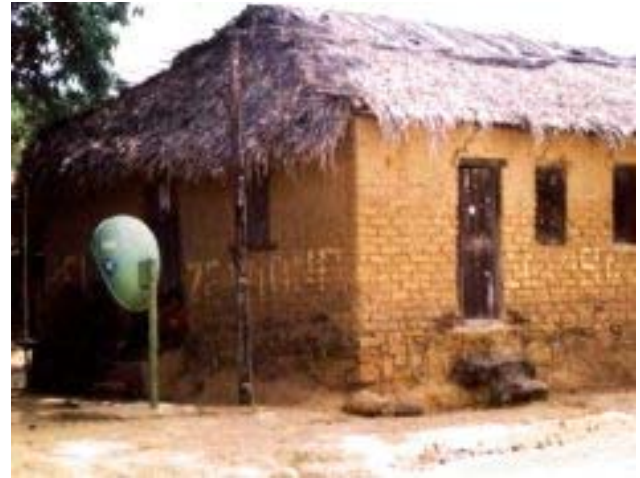
Figura 5.19 Vila do Rosário – Padrão construtivo típico - Tijolo de adobe
