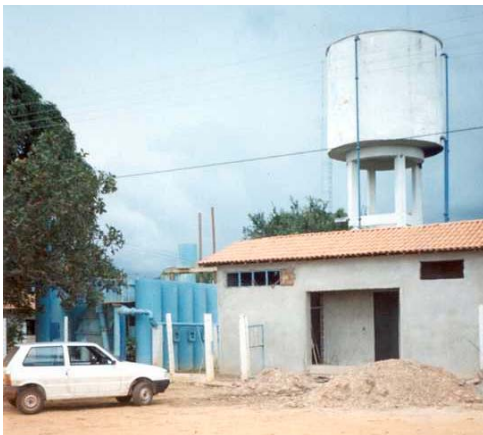
Figura 3.9 Estação de tratamento de água e reservatório – Paranã
