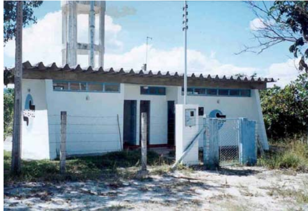
Figura 3.13 Estação de tratamento de água – Cavalcante
