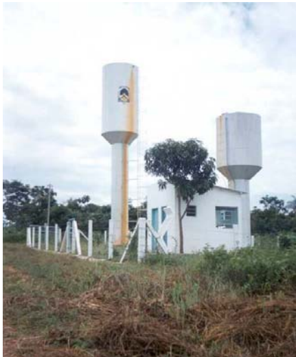
Figura 3.11 Saneatins – Reservatório São Salvador do Tocantins
