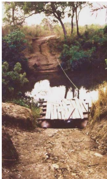
Figura 5.13 Rio Custódio – Margem direita – Local de travessia por balsa, que atende a comunidade de Custódio e o vilarejo de Rosário
