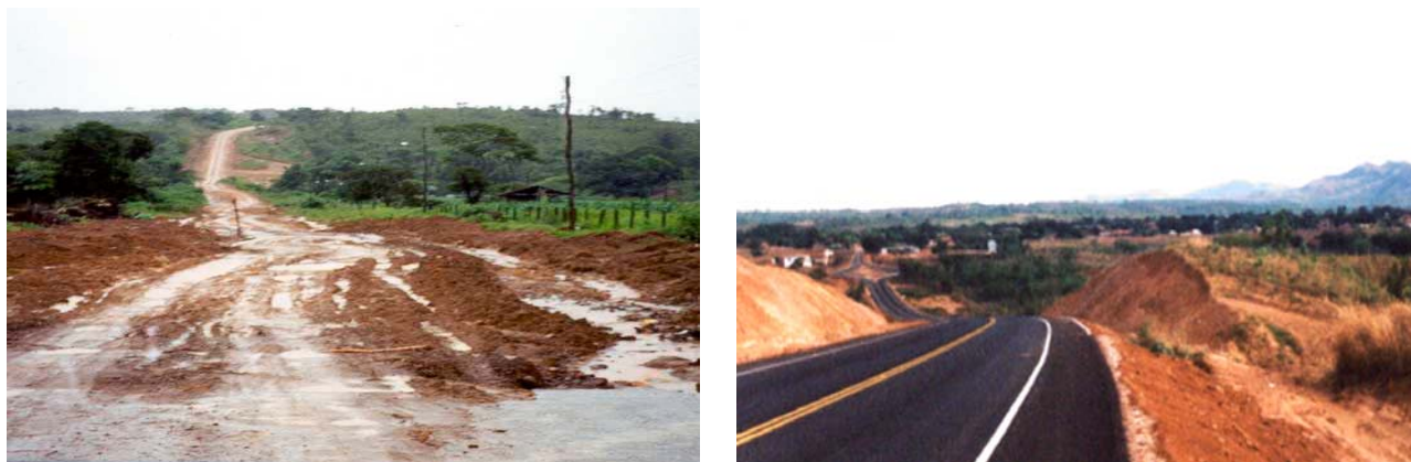
Figura 3.3 Estrada São Salvador - Palmeirópolis -TO-387 à esquerda, condições anteriores à pavimentação. À direita, estrada já pavimentada
