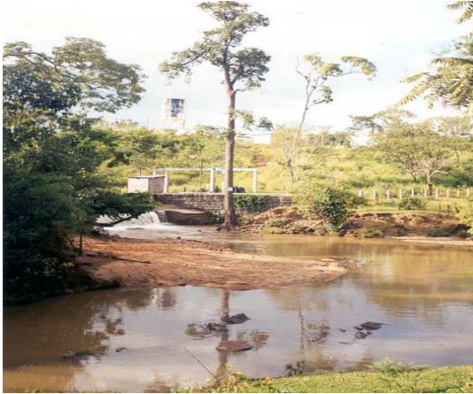
Figura 3.14 Captação Saneago – Minaçu
