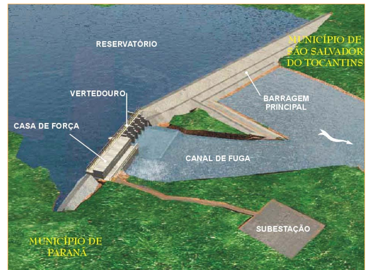
Figura 3.7. Finalização das obras e formação do reservatório.
