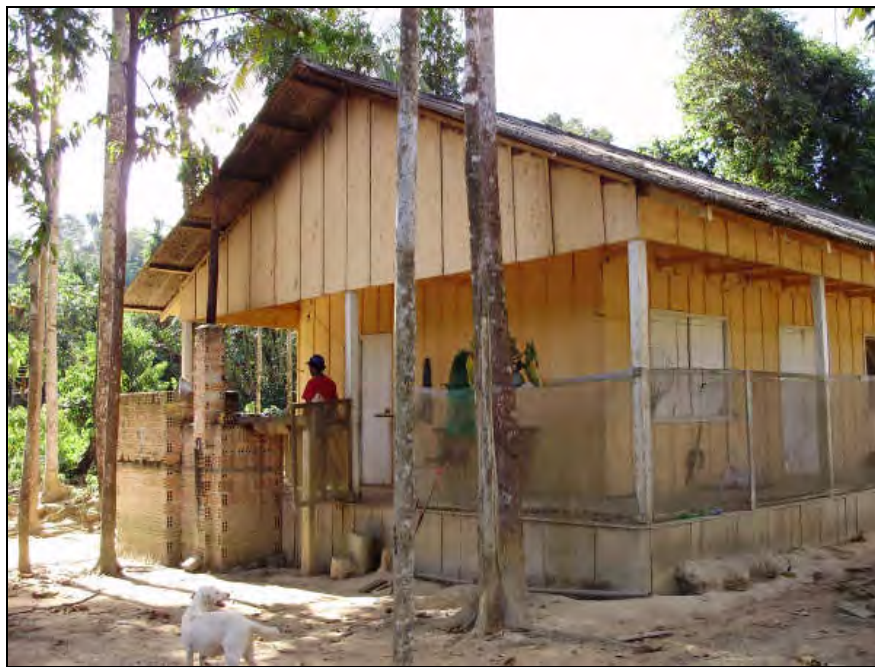
Foto 04 - Residência do responsável pelo campo de pouso, localizada nas proximidades da pista.
