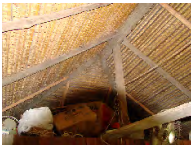
Foto 04 - Aspecto da cobertura com folhas de palmeira.
