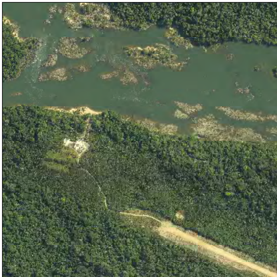
Foto 13 - Vista do campo de pouso e residências de barqueiros (ortofoto SAI-0649).
