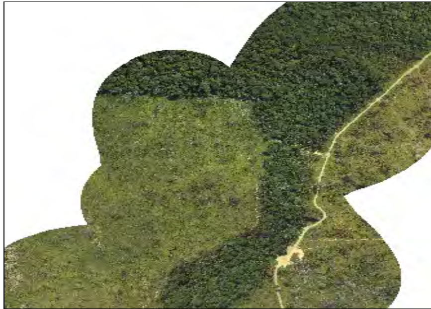
Fotos 03 - Estrada interna e barragem de curso d'água para dessedentação de animais
