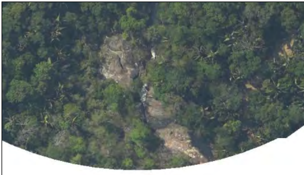
Foto 04 - Localização da Micro Central Hidrelétrica ortofoto SAI-0511).
