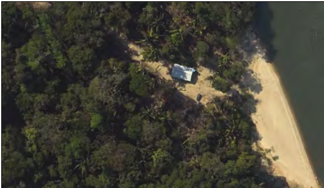
Foto 02 - Fase inicial de construção da pousada (agosto de 2007).
