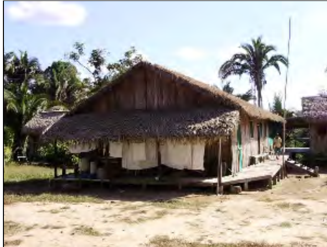
Foto 06 - Prédio da lavanderia e dormitório de pilotos.
