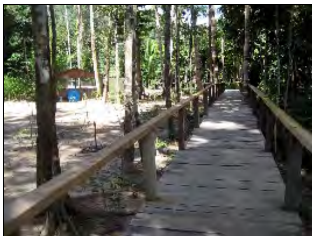
Foto 05 - Continuação da passarela até as margens do rio Teles Pires.
