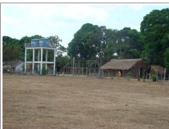
Caixas d'água para distribuição de água e residência em construção.
