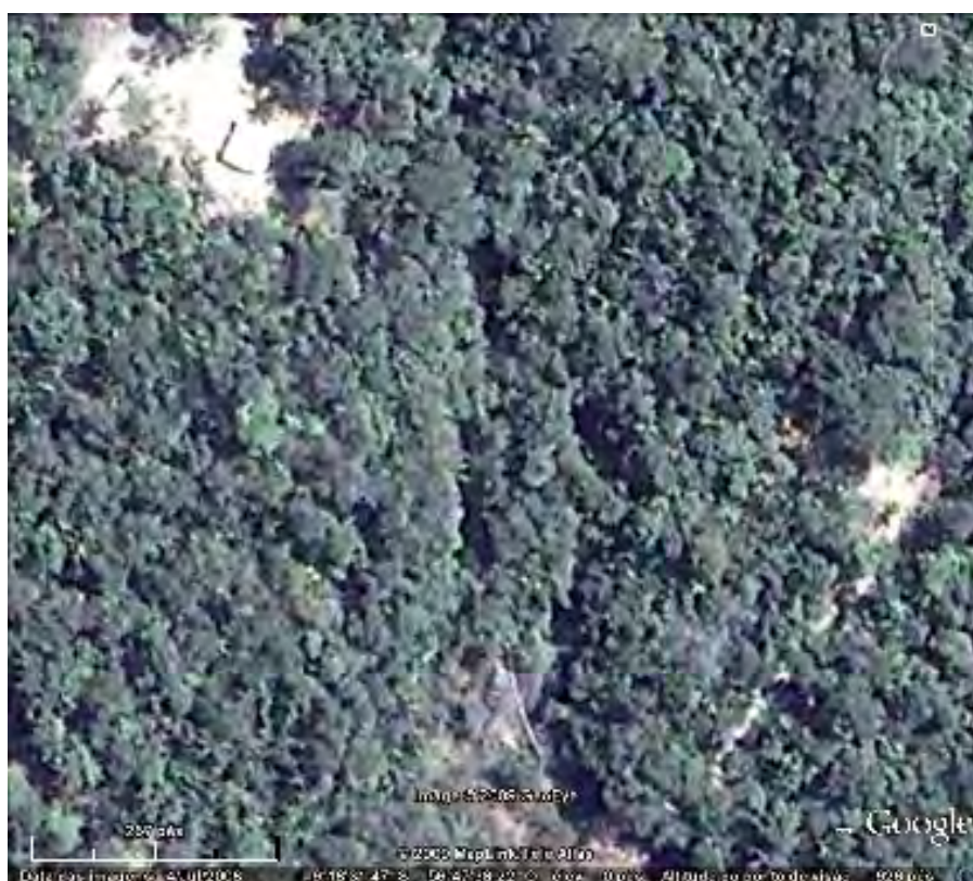
Foto 02 - Imagens aéreas das benfeitorias afetadas, casa e mch (Micro Central Hidrelétrica) da Fazenda Rancho do Jundiá.
