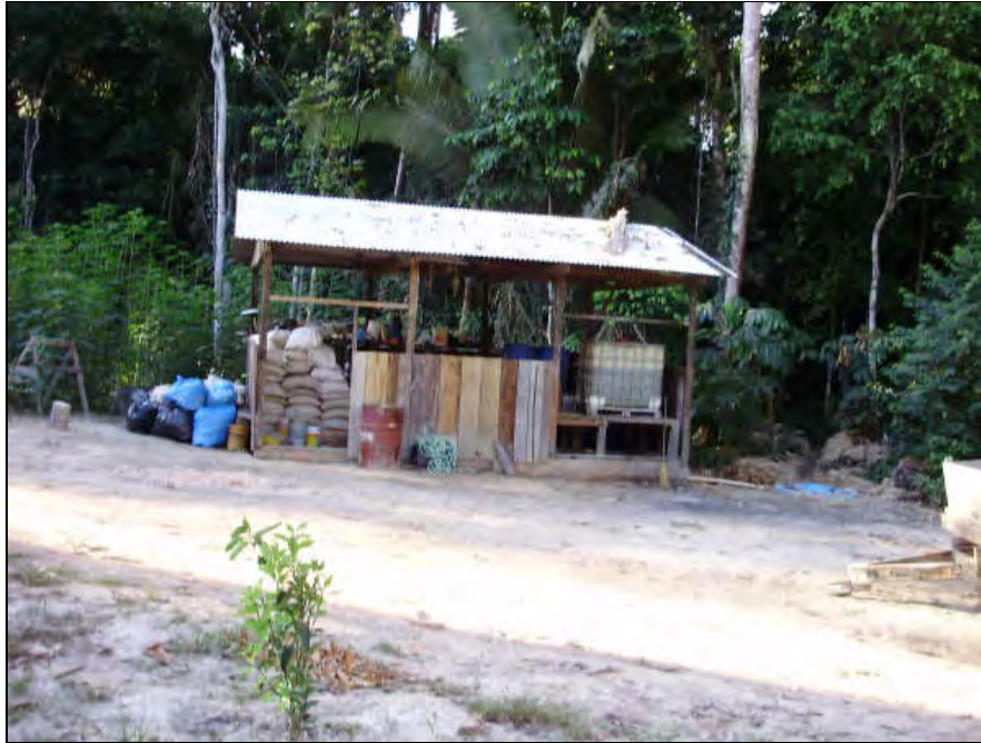
Foto 11 - Depósito de combustível e material de construção.
