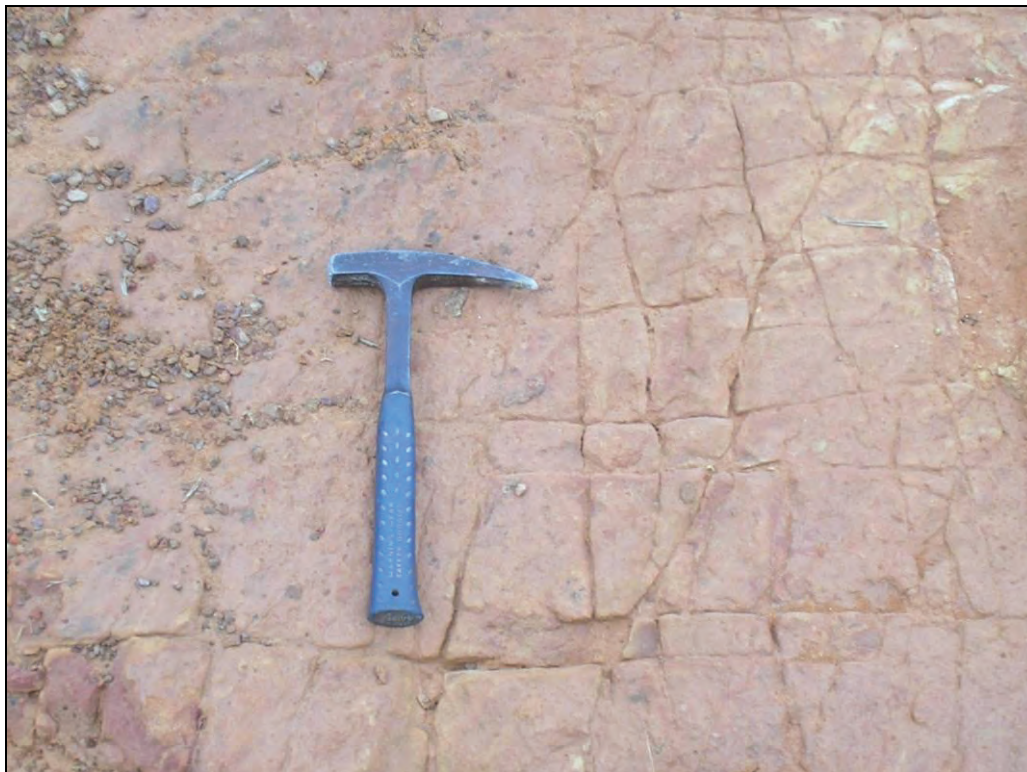
Foto 2.5-6 – Argilitos da Unidade II do Grupo Beneficente alterados e fraturados
