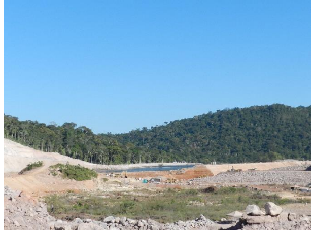
Foto 1-14 Ponto 16 (Canteiro de obras próximo à barragem).
