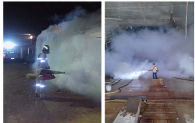
Figura - 17: Atividades Termonebulização na área do Canteiro de obras – UHE São Manoel
