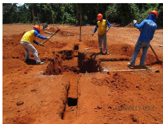
Figura - 17: Vista geral da execução das fundações.
