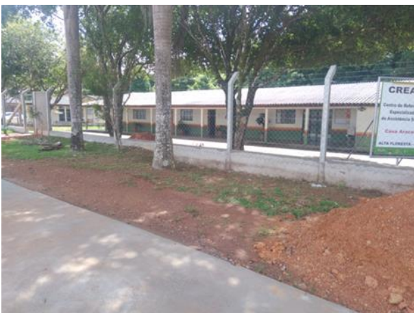
Figura - 7: Vista geral do CREAS – Muro e calçada.
