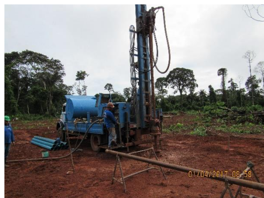
Figura - 15: Vista geral da perfuração do poço artesiano.
