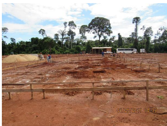
Figura - 16: Vista geral da execução das fundações.
