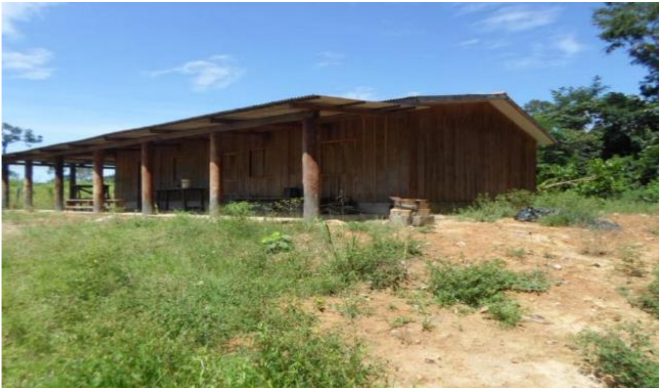
Foto ilustrativa. Imagem de cadastro físico UHE São Manoel.
