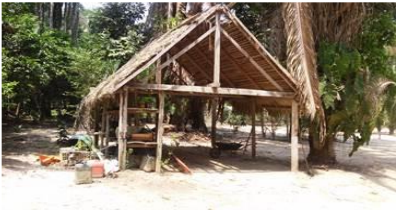
Foto ilustrativa. Imagem de cadastro físico UHE São Manoel.
