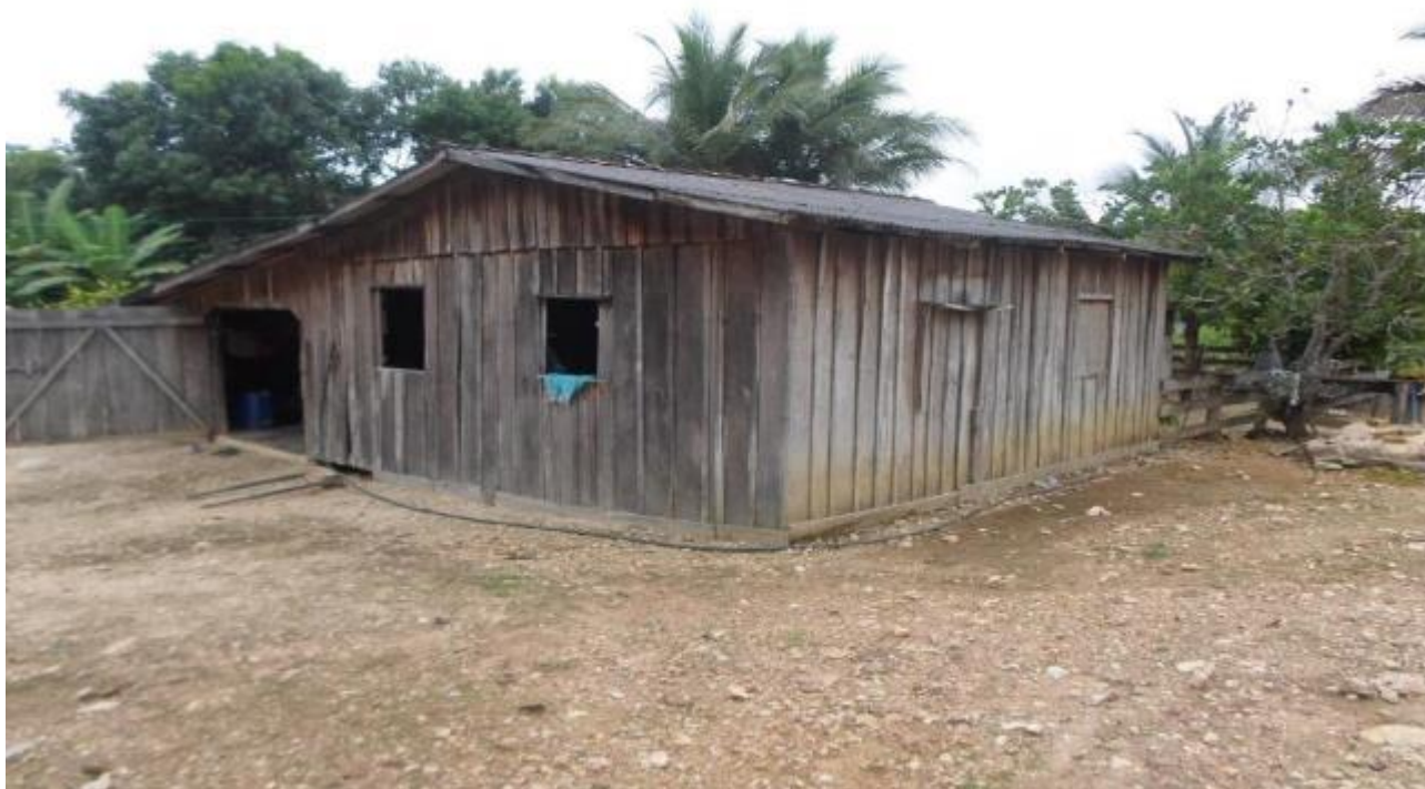
Foto ilustrativa. Imagem de cadastro físico UHE São Manoel.
