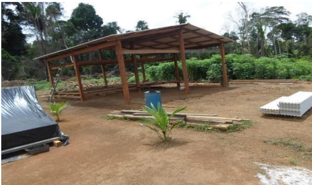
Foto ilustrativa. Imagem de cadastro físico UHE São Manoel.
