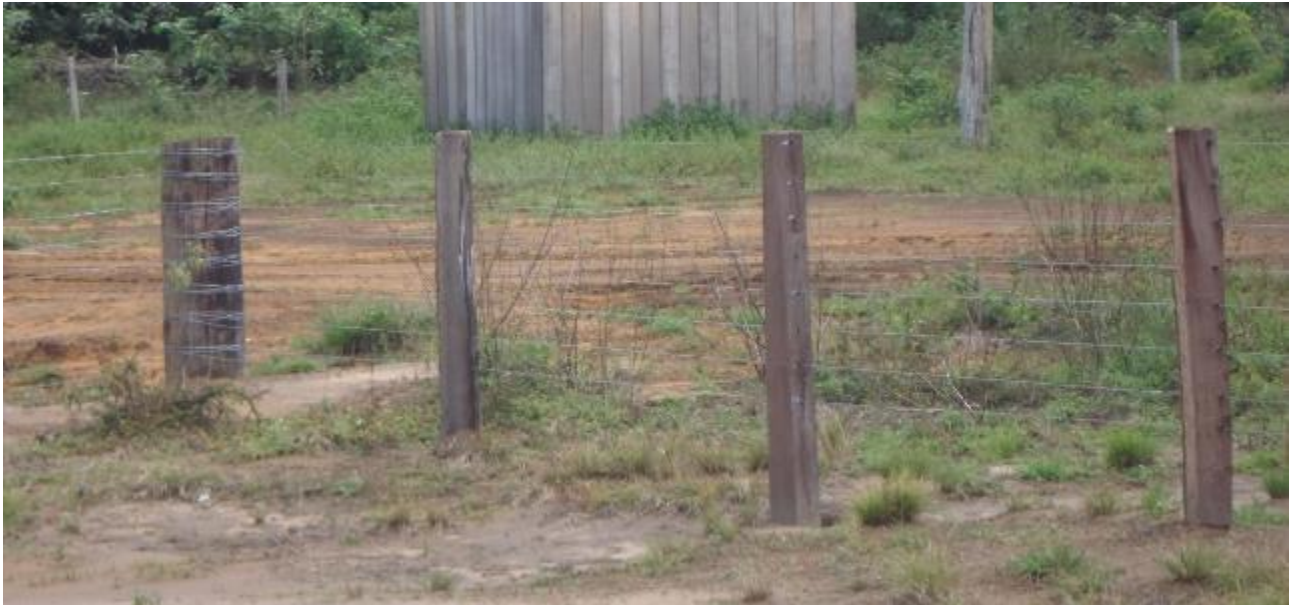
Foto ilustrativa. Imagem de cadastro físico UHE São Manoel.
