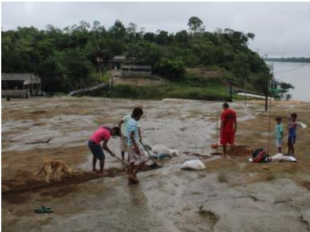
Figura 10 - Instalação do Telefone de Utilidade Pública (TUP), na aldeia Mayrowi
