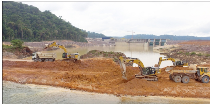
Retirada da enscadeira de jusante
