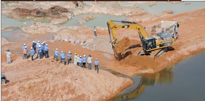
Desvio de segunda fase do rio Teles Pires
