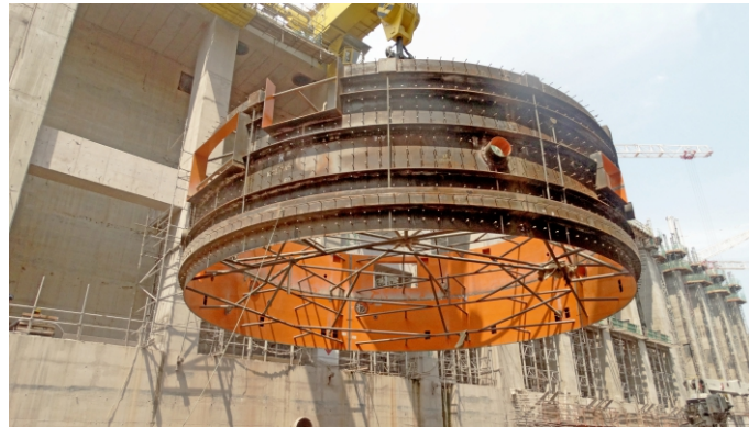
Içamento da Blindagem do Poço da Turbina UG-01
