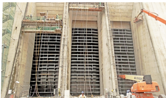
Tomada D'Água - Comporta Ensecadeira - TA 01 - Vãos 01, 02 e 03
