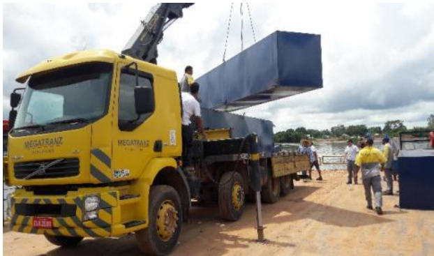
Instalação de flutuadores extras na balsa.
