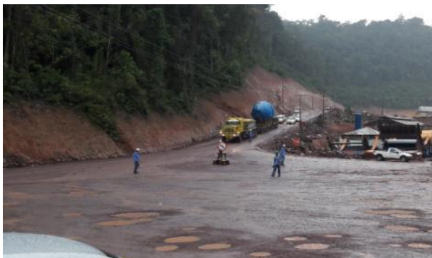
Chegada do comboio no canteiro de obras.
