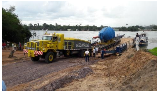
Viga com o Rotor finalizando a travessia da balsa.
