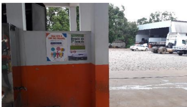
Posto de combustível em Paranaíta
