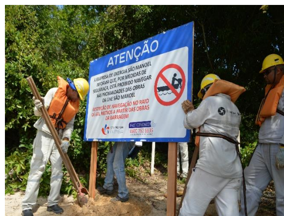
Placas foram instaladas a montante e a jusante
