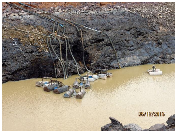
Figura 12. Bombas utilizadas para reduzir o nível de água da ensecadeira.
