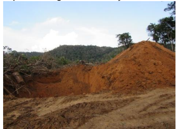
Figura 1-18: Valas abertas para enterrio dos resíduos submetidas a vistorias pela equipe do resgate de fauna.
