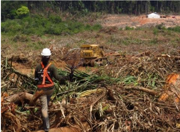
Figura 1-13: Equipe do resgate de fauna acompanhando o enleiramento do resíduo vegetal em área suprimida no canteiro de obras.
