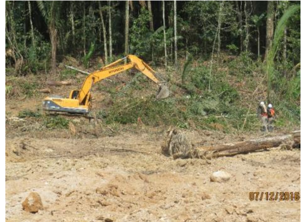
Figura 1-14: Acompanhamento da limpeza da área suprimida.
